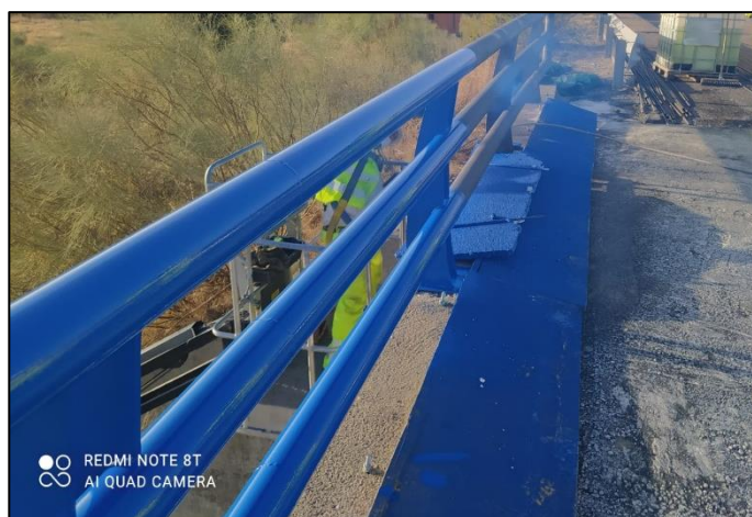
Imagen 30. Repintado de pretilas con pintura protectora.
