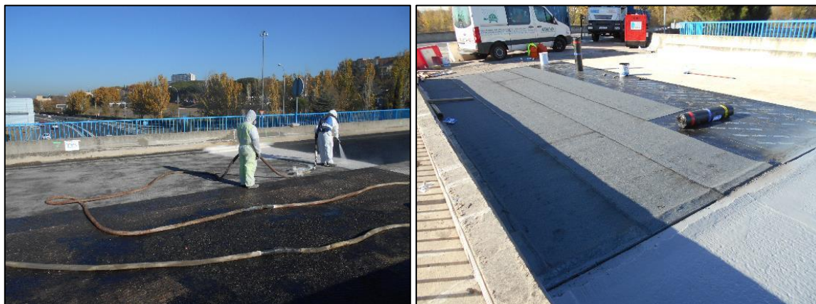
Imagen 5. Actuaciones de impermeabilización del tablero.
