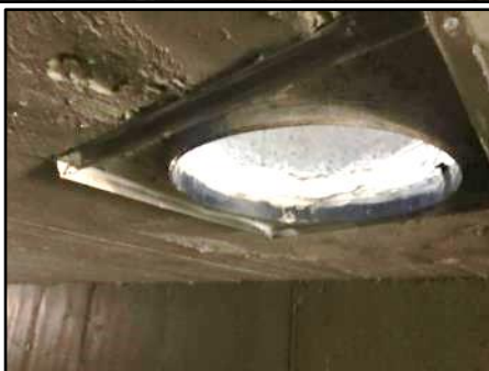
Imagen 15. Prolongación del pozo con lámina de fibra de carbono.
