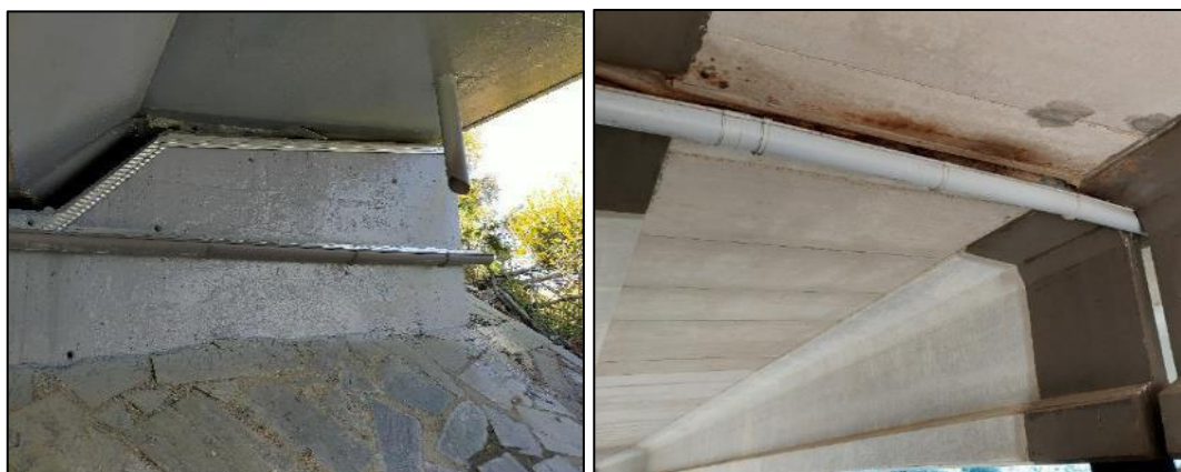
Imagen 13. Canalones de recogida de agua en coronación de estribo y bajo junta de dilatación.
