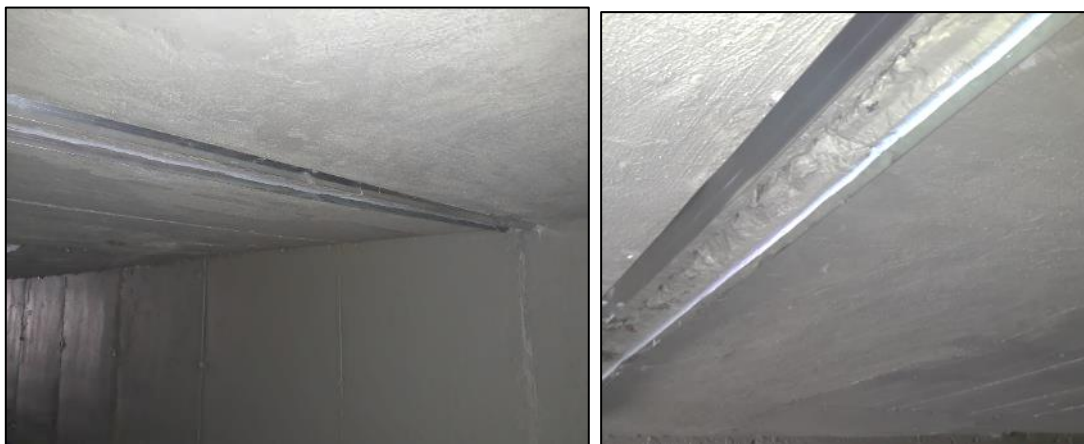
Imagen 17. Colocación de vierteaguas a ambos lados de las juntas de los marcos.
