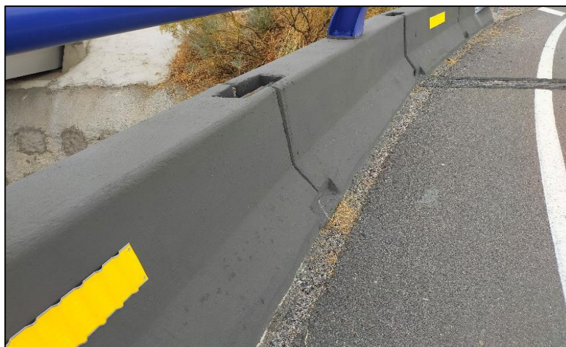
Imagen 27. Pretil mixto tras reparación.
