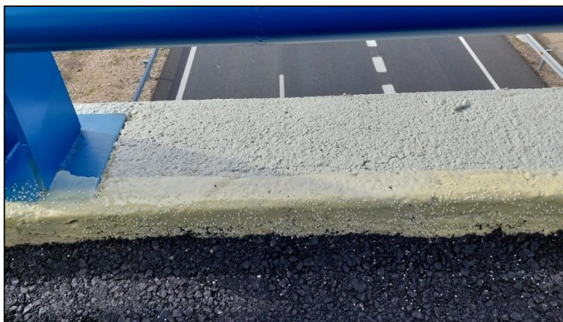
Imagen 31. Reparación de zócalos de pretila metálica.
