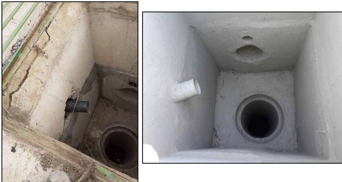
Imagen 16. Actuaciones de reparación, sellado e impermeabilización de arquetas existente en mediana.
