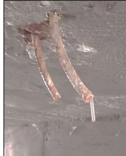
Imagen 19. Colocación de tubos de drenaje en la losa superior del marco.
