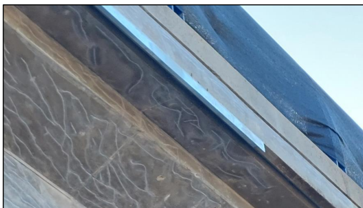
Imagen 7. Instalación de vierteaguas en el borde del tablero.
