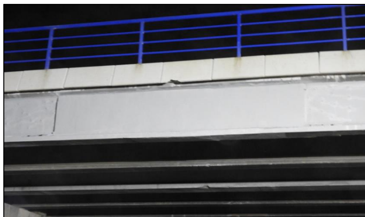
Imagen 22. Proyección de mortero de reparación y tratamiento anticarbonatación.
