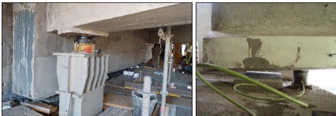
Imagen 35. Actuaciones de sustitución de aparatos de apoyo.
