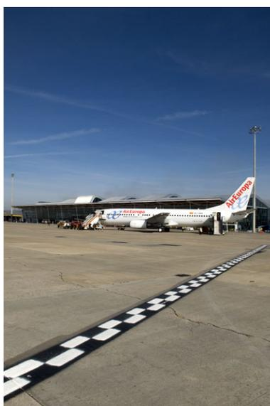
La plataforma comercial cuenta con torres de alumbrado para su iluminación, además de estar dotada de balizamiento de señalización de borde de plataforma.
