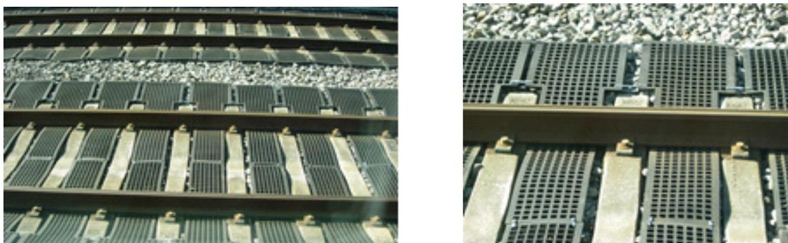
**Figura A5.7.** Protección japonesa para evitar el vuelo del balasto.
