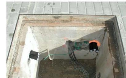
La salida de los subconductos será perpendicular a la pared de la arqueta.
