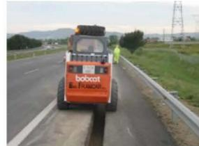
La distancia entre el borde la zanja y las tierras procedentes de la excavación ha de ser como mínimo de 1m.
