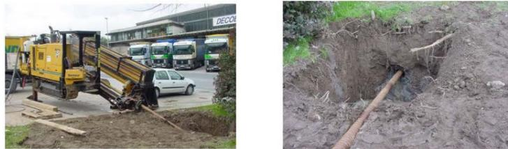
El motivo u objeto de instalar tubería de P.V.C. de  $\varnothing$  110 mm. en la camisa de acero tiene la ventaja de que en cualquier momento se puede sustituir el subconducto por un cable de mayor diámetro ó instalar otro servicio además de independizar cualquier tipo de cable, tubería, etc.
