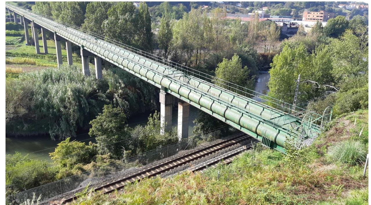
Fotografía 3. Conducciones de agua red primaria CABB
