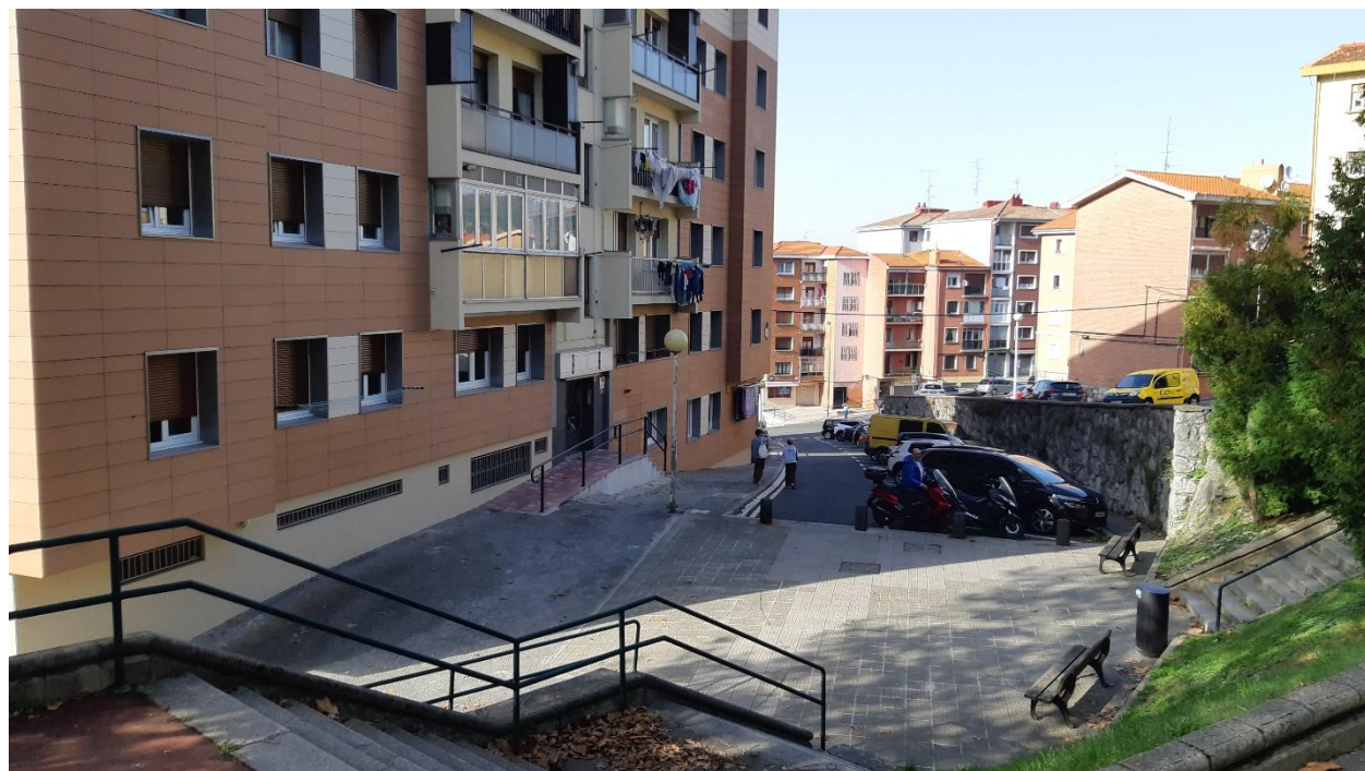
Fotografía 14. Salida de emergencia en grupo Aldapeta
