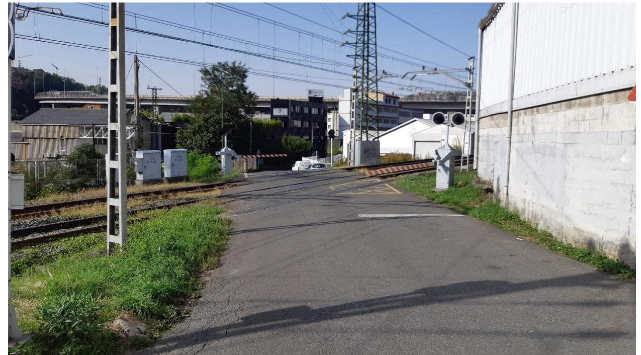
Fotografía 7. Paso a nivel Zorrozoiti a levantar
