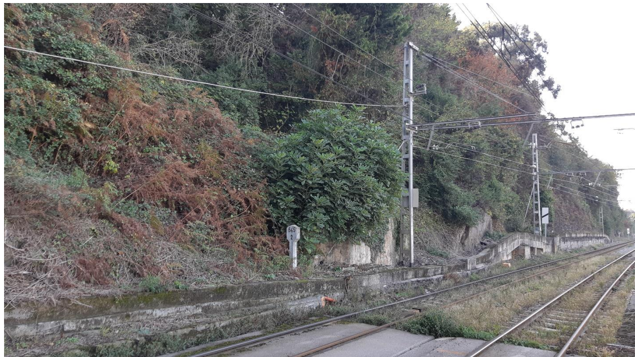
Fotografía 22. Media ladera y muro en PK 1+500
