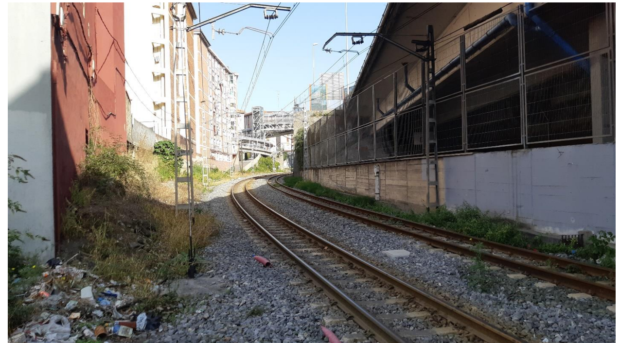
Fotografía 11. Línea ferroviaria a suprimir
