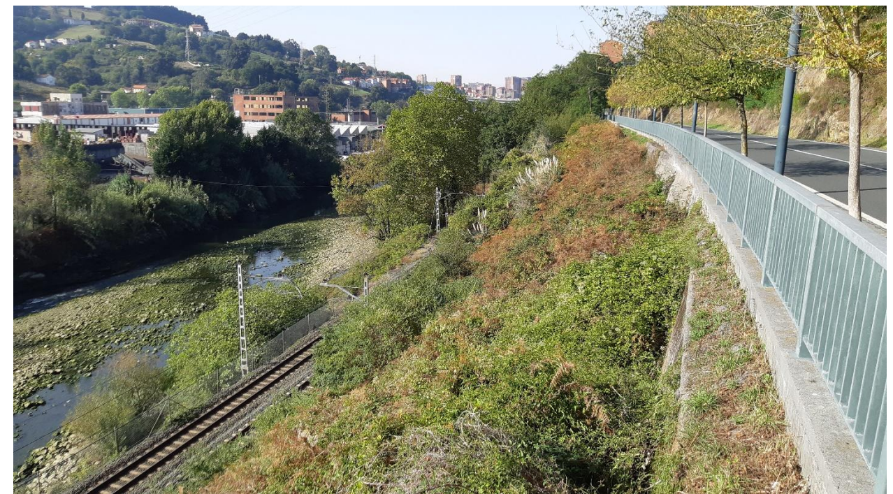
Fotografía 4. Media ladera con muro PK 0+100 y emboquille
