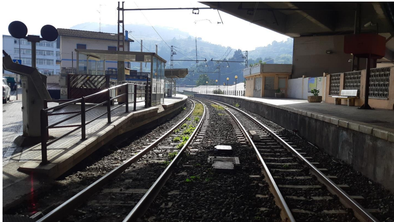
Fotografía 9. Estación de Zorrotza a eliminar
