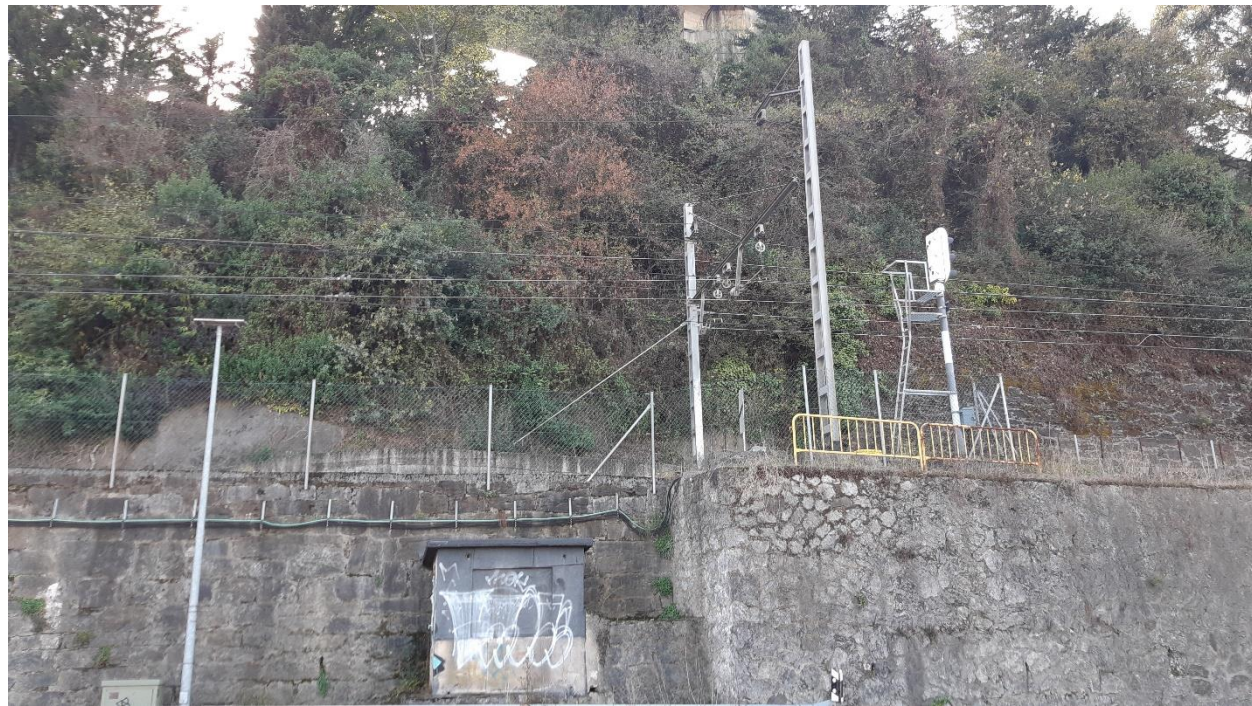
Fotografía 21. Emboquille de salida avda. Montevideo
