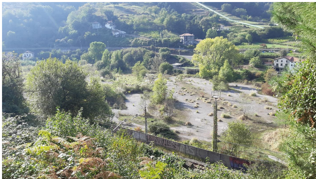
Fotografía 2. Explanada existente para instalaciones
