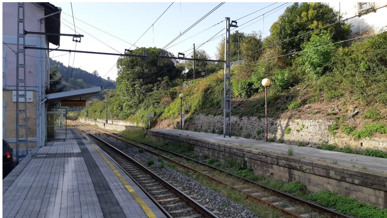
Fotografía 26. Apeadero de Santa Águeda
