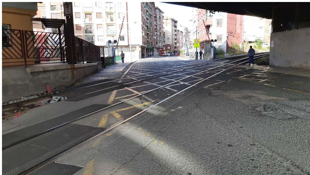
Fotografía 10. Paso a nivel de Zorrotza a suprimir
