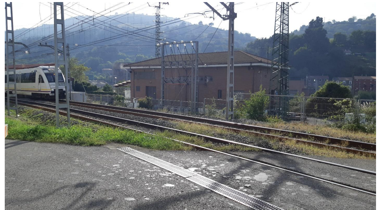
Fotografía 8. Subestación eléctrica y base de mantenimiento a eliminar
