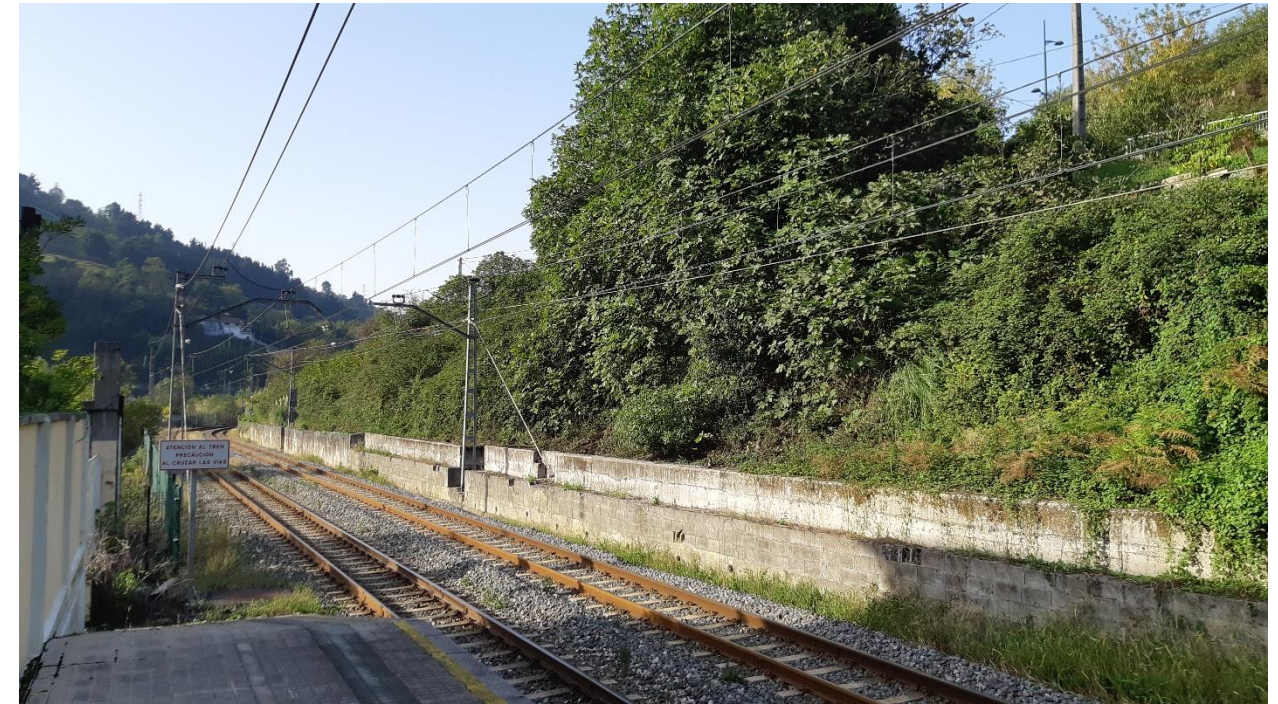
Fotografía 27. Zona de ubicación de nueva SE
