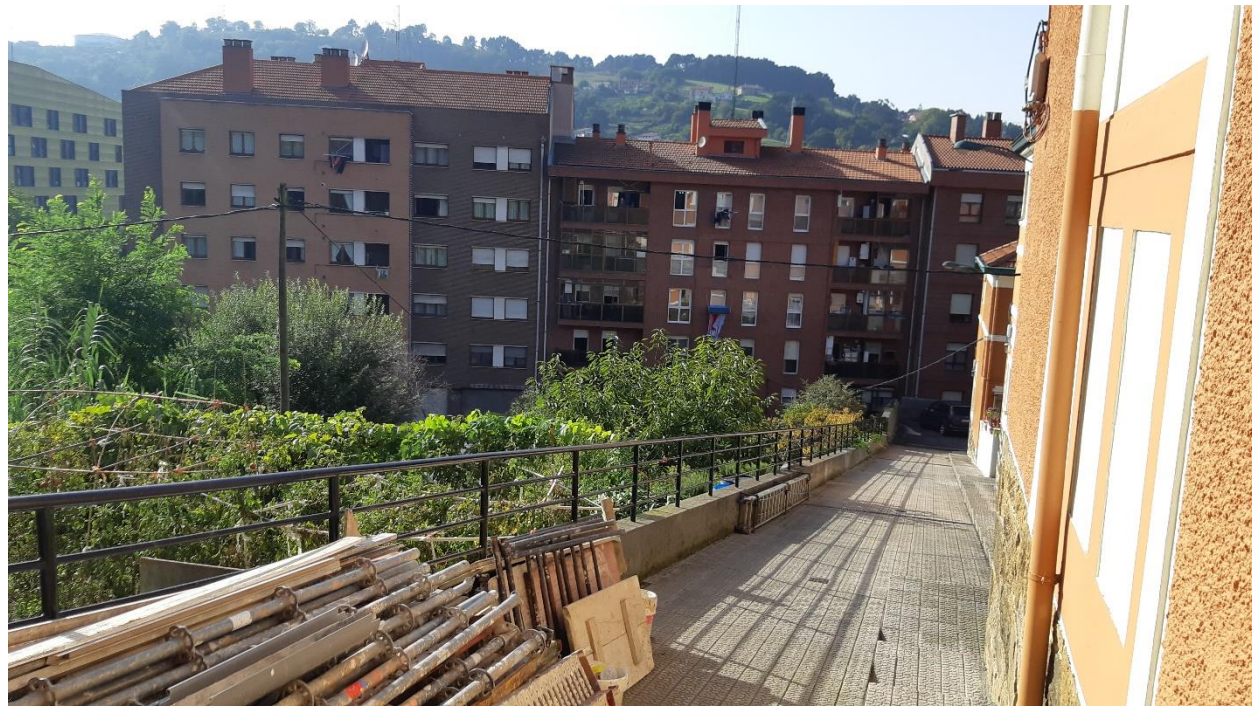
Fotografía 13. Ubicación ventilación de emergencia sur
