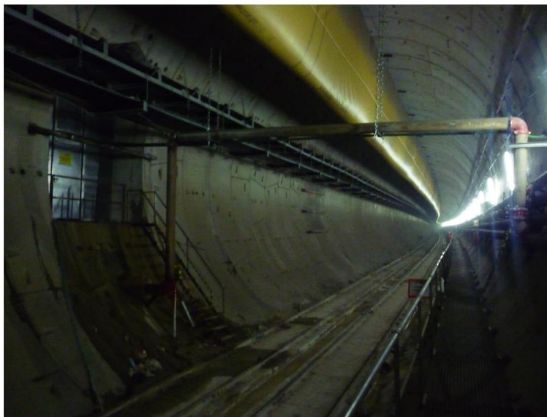
Figura 7. Túnel en construcción mediante TBM con revestimiento de dovelas de hormigón prefabricadas
