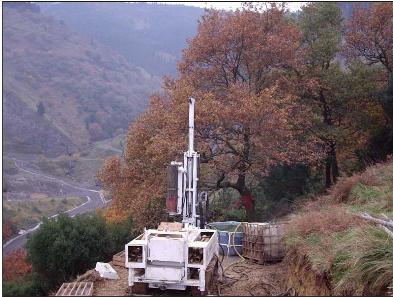
Emplazamiento del Sondeo SPT-27
