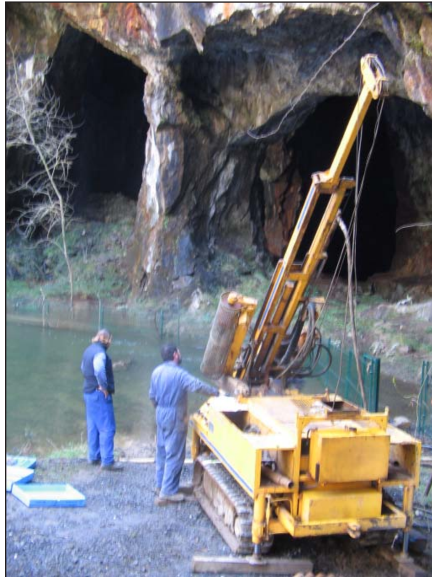
Emplazamiento del Sondeo SPT-24
