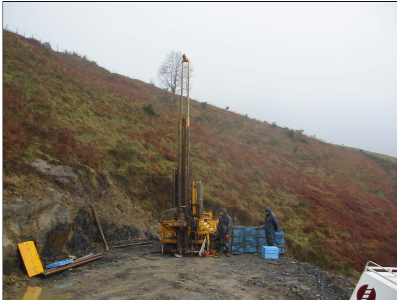
Emplazamiento del Sondeo SPT-26
