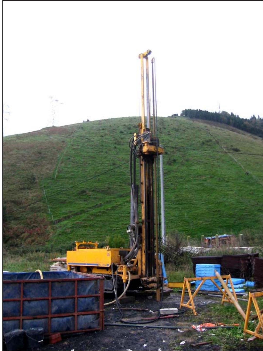
Emplazamiento del Sondeo SPT-31
