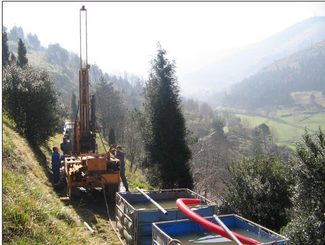
Emplazamiento del Sondeo SPT-29
