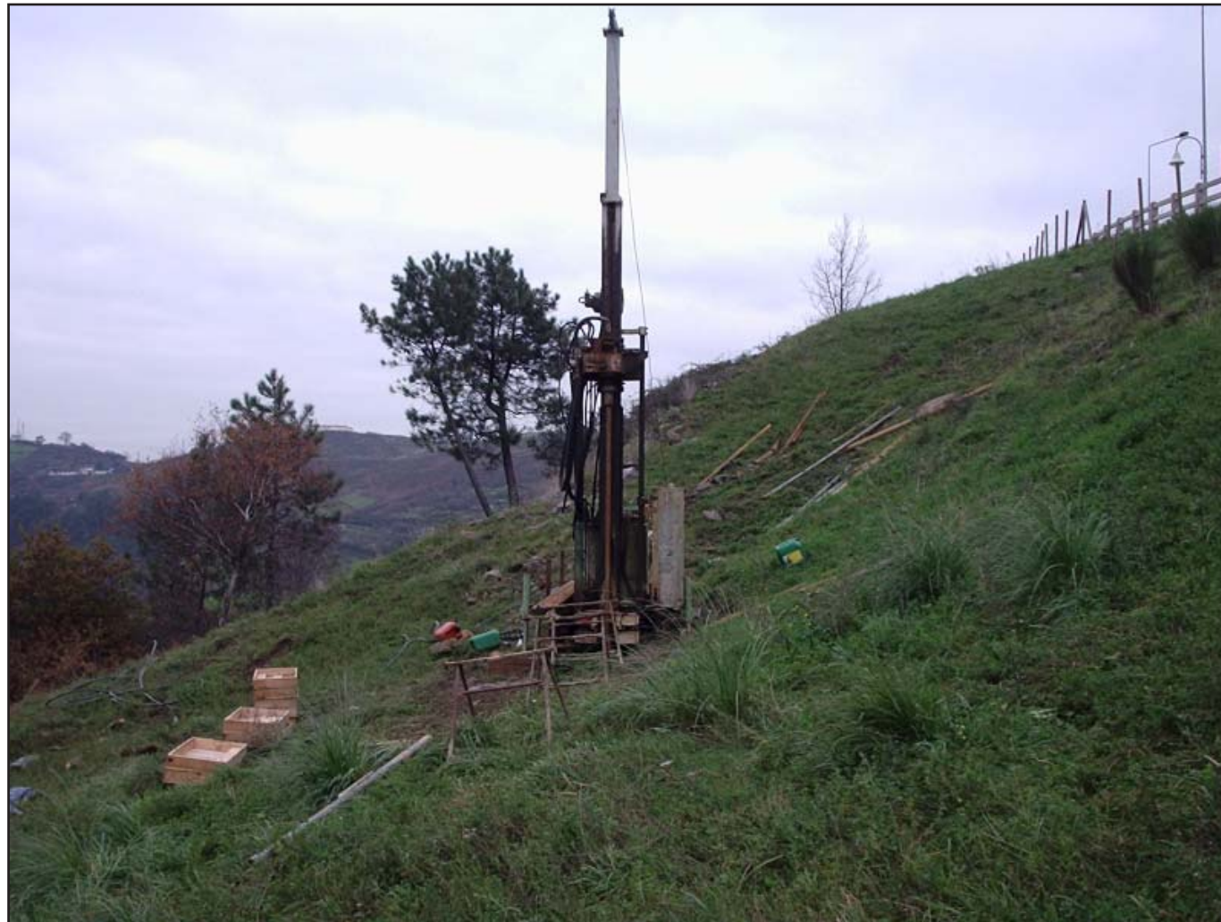
Emplazamiento del Sondeo SPT-20
