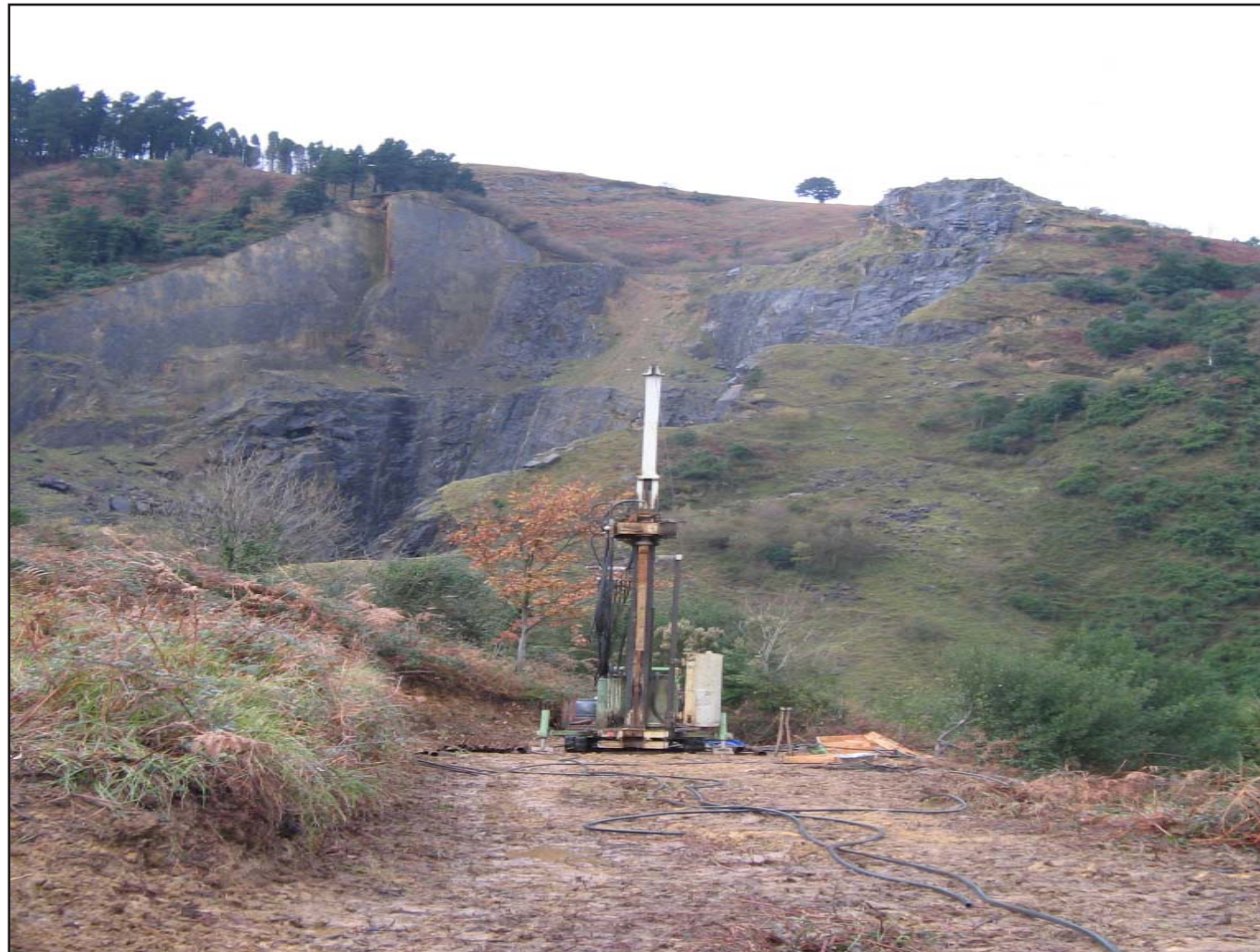
Emplazamiento del Sondeo SPT-28
