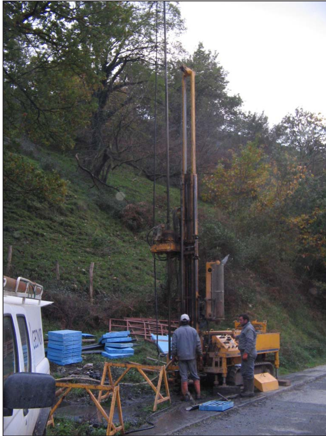
Emplazamiento del Sondeo SPT-32
