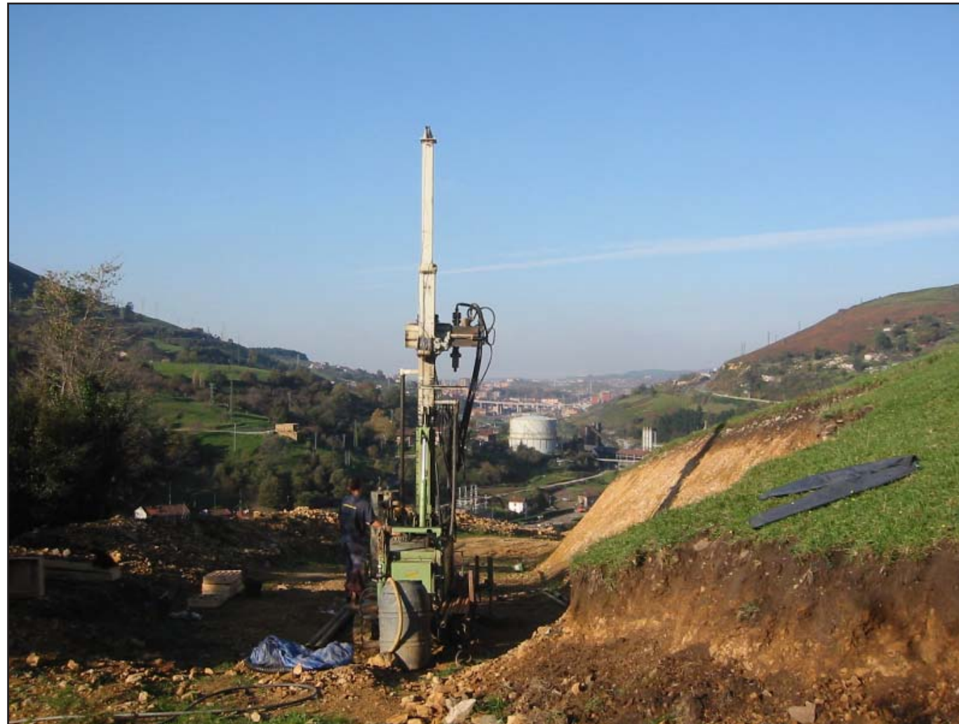
Emplazamiento del Sondeo SPT-22
