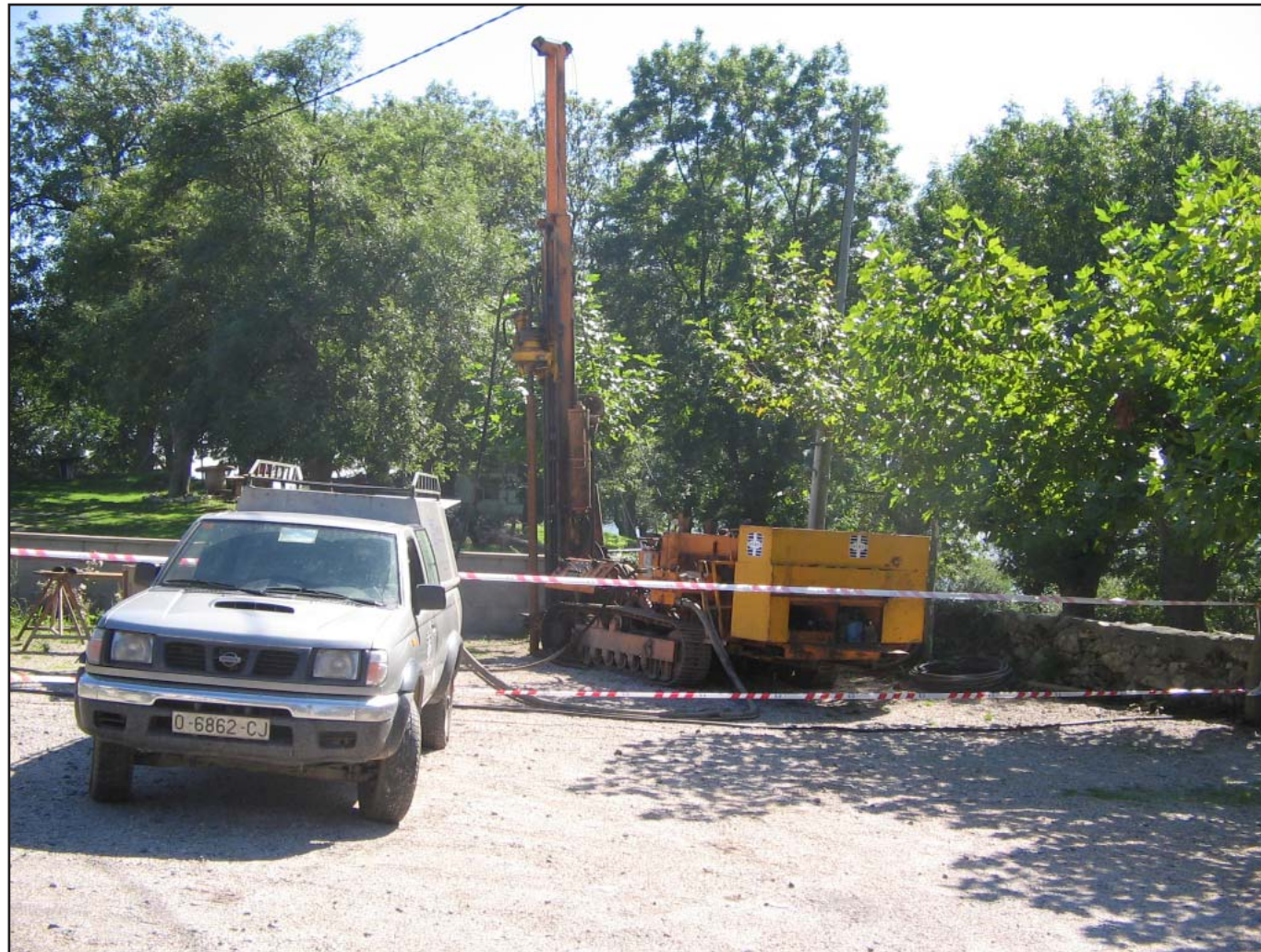
Emplazamiento del Sondeo SPT-1
