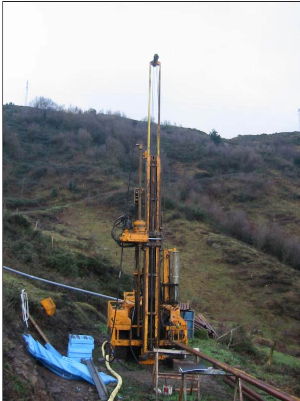
Emplazamiento del Sondeo SPT-25
