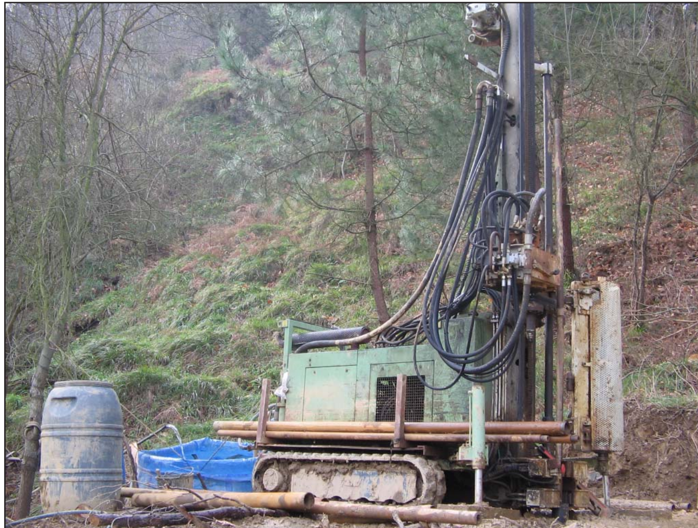
Emplazamiento del Sondeo SPT-30
