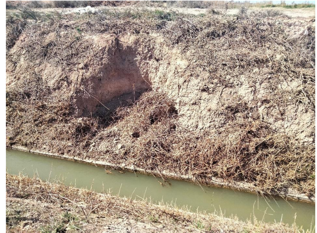
Figura 5.- Terraza aluvial, en zona de riego, sobre yesos, en P.K. 1+400 (T4 alternativa 2 Oeste).
