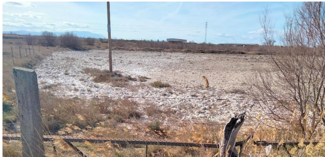
Figura 7.- Subsistencia con yesos aflorantes en P.K. 4+000 (T4 alternativa 2 Oeste).
