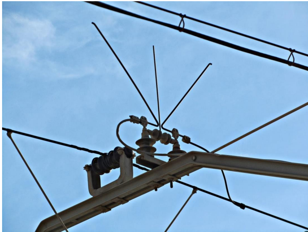
Explosores de protección contra sobretensiones con varilla central antipájaros
