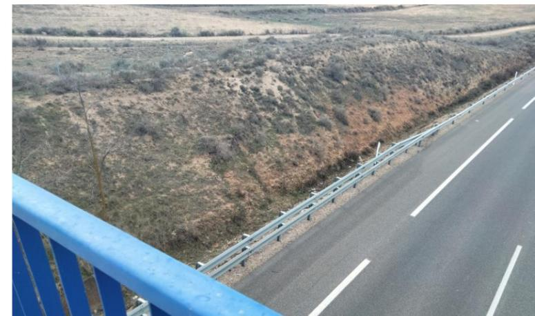
Figura 26.- Talud excavado al 1H:1V en AP-68
