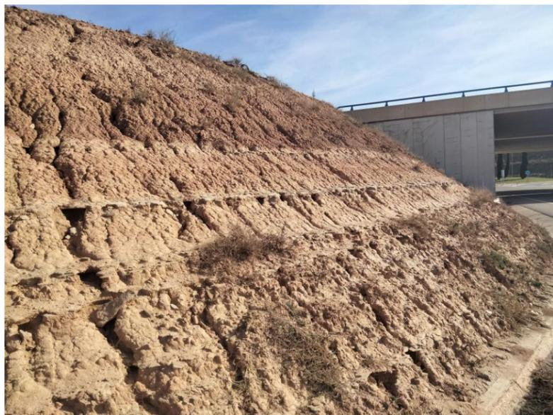
Figura 30.- Talud excavado en el terciario en la entrada al polígono industrial la Serna.
