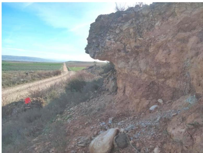
Figura 15.- Erosión diferencial entre margas y conglomerados en el P.K. 312+000
