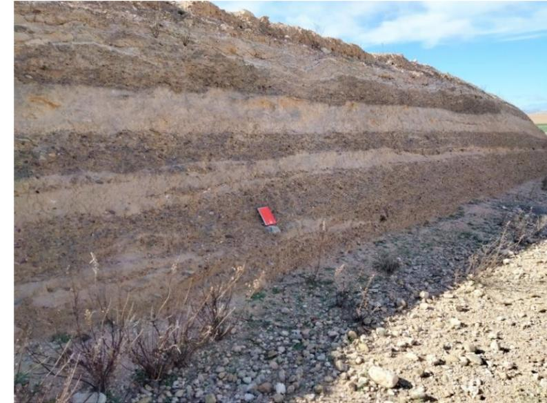
Figura 24.- Talud excavado en Glacis, alternancia de gravas, arenas y limos.
