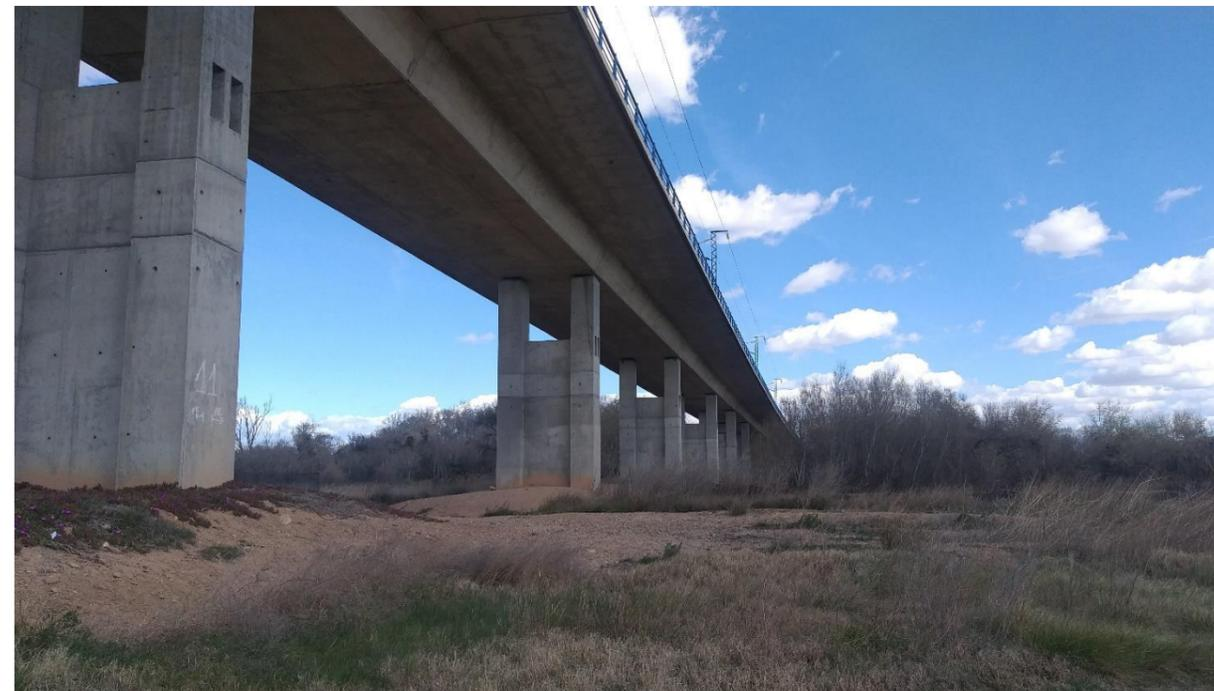
**Fotografía (Tramo 1) 3.-** Viaducto LAV sobre el río Jalón. Aparente Puente de sección losa de luces 30 m aproximadamente
