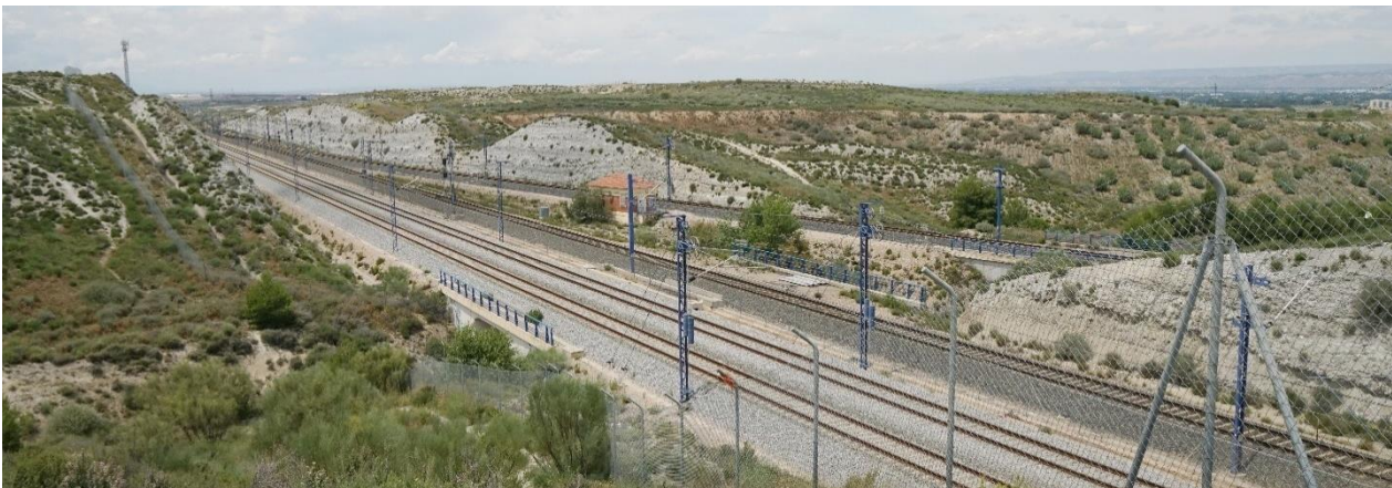
Figura 8-4. Desmonte del corredor actual en depósitos terciarios.
