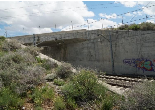
Figura 4–2. Cruce de vías de acceso a Plaza bajo ramal LAV Madrid - Barcelona
