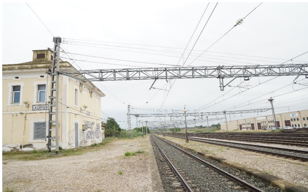
Figura 4-4. Estación de la Cartuja. Vista hacia Caspe/Barcelona
