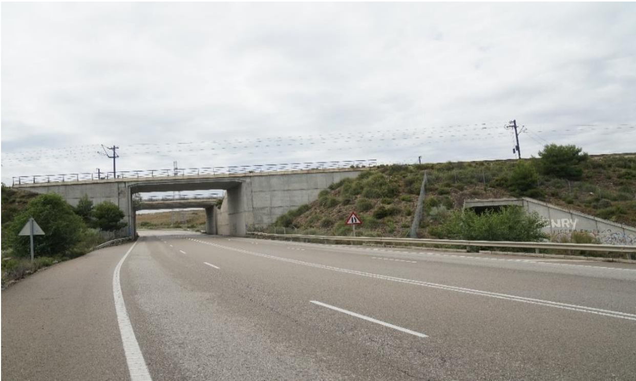
Figura 4–3. Pasos inferiores de la carretera CV-624
