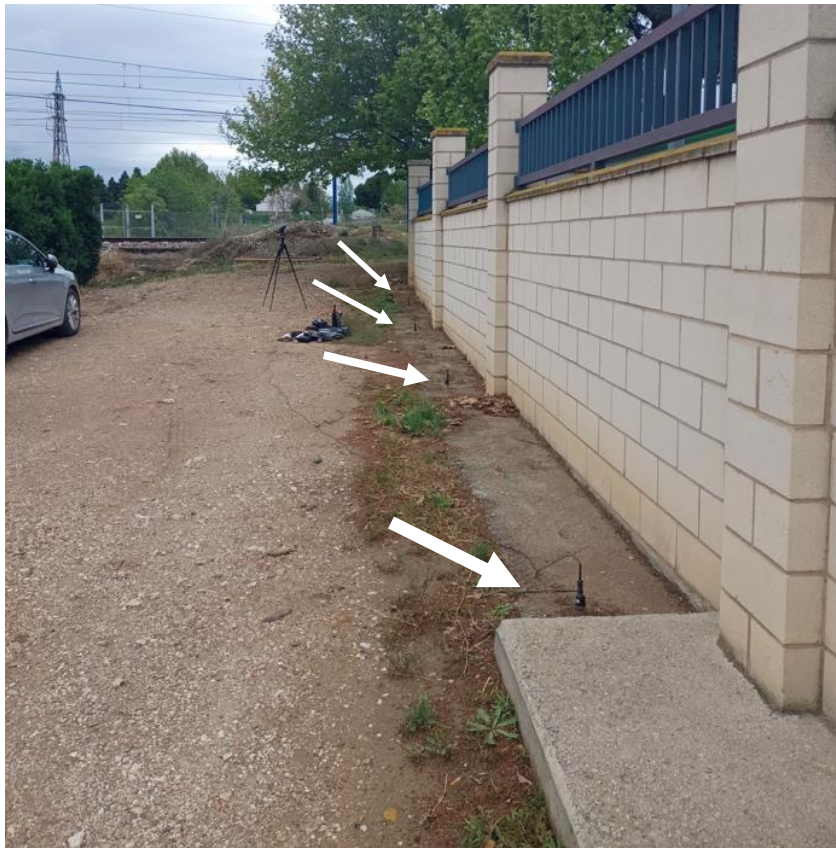
Figura 3.16. Vista de los acelerómetros utilizados para caracterizar la propagación de vibraciones a través del terreno.
