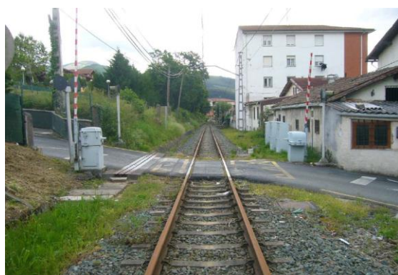
Imagen desde el eje de la vía en sentido creciente de PK
