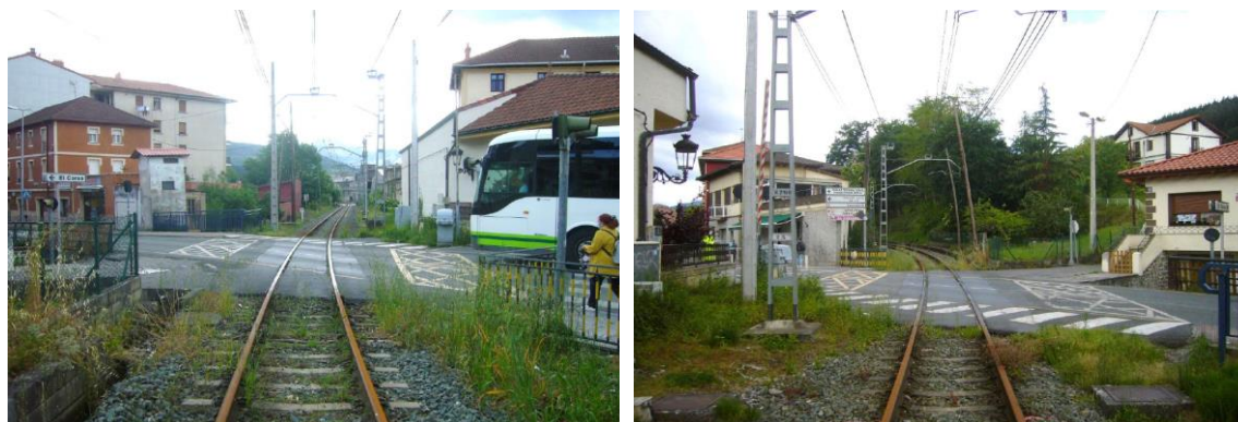
Imagen desde el eje de la vía en sentido creciente de PK
