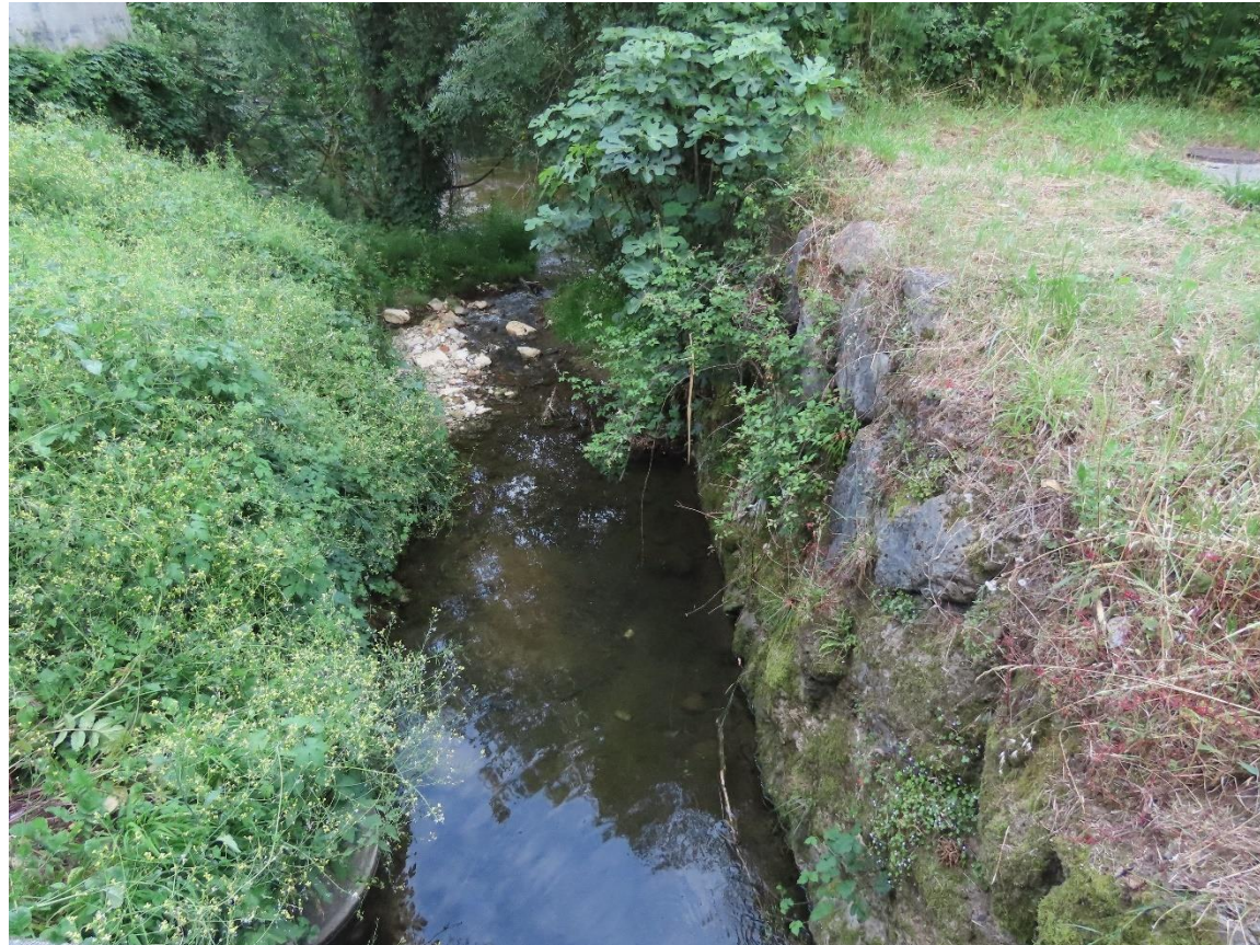
Vista del arroyo Maruri próximo a la desembocadura en el Cadagua. Riberas comprimidas y alteradas, con escolleras de protección. Población de Zalla. Fuente: elaboración propia
