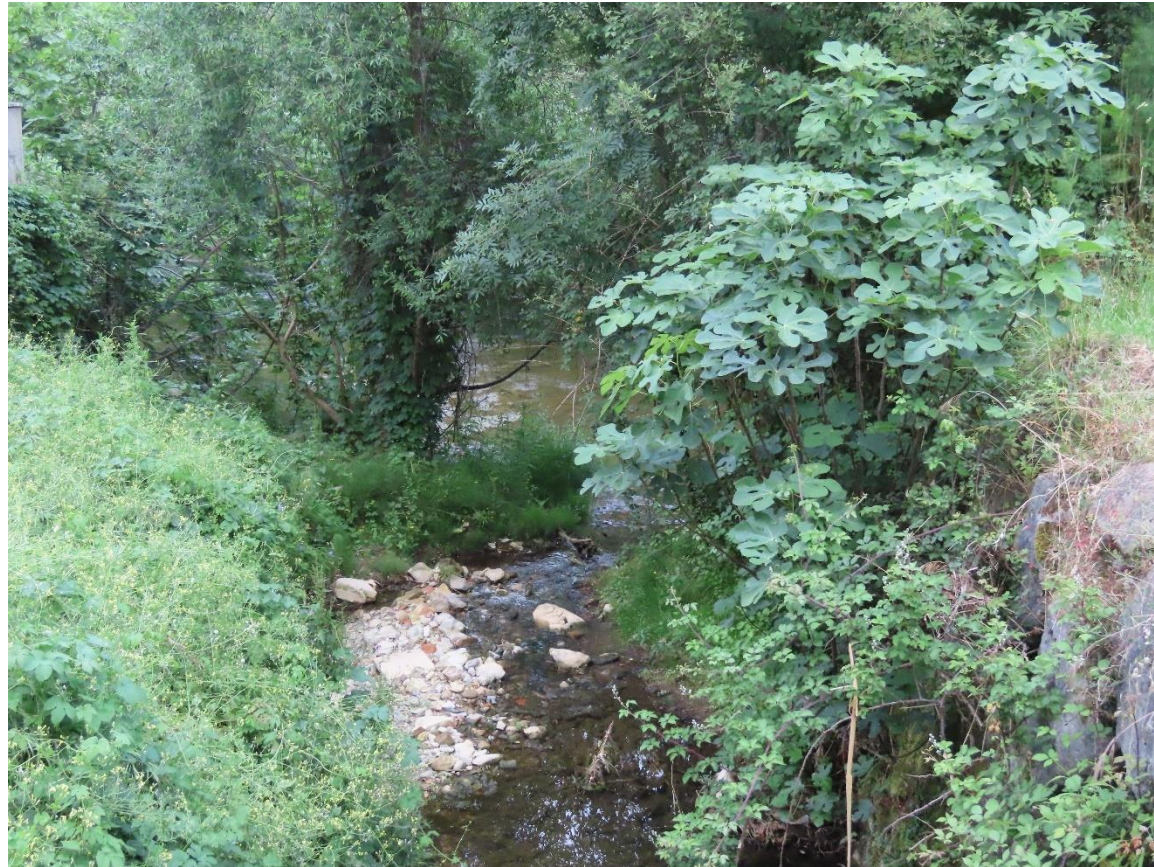
Juntas del arroyo Maruri con el río Cadagua. Se aprecia la escollera de protección. Fuente: elaboración propia
