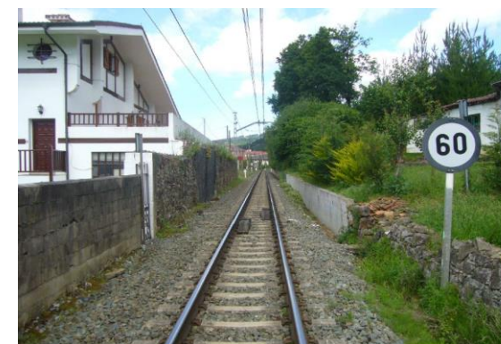
Imagen desde el eje de la vía en sentido creciente de PK
