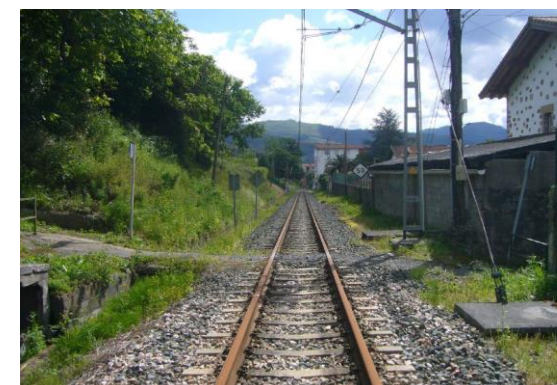
Imagen desde el eje de la vía en sentido creciente de PK
