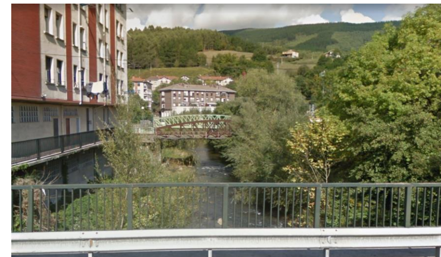
Puente actual de la línea ferroviaria 790 “Asunción Universidad – Aranguren” sobre el río Cadagua. Fuente: Google Maps
