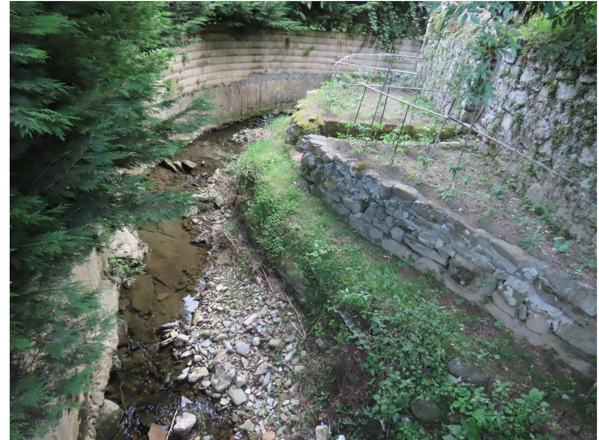
Arroyo Maruri cerca de su desembocadura en el Cadagua. Se aprecia la elevada artificialidad y alteración del curso fluvial, con una canalización total del cauce. Fuente: elaboración propia
