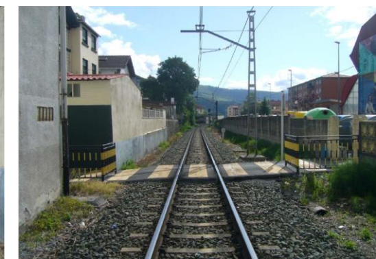
Imagen desde eje de vía en sentido decreciente de PK
