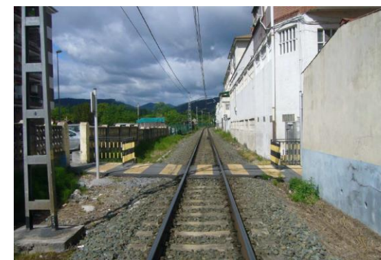
Imagen desde eje de vía en sentido creciente de PK
