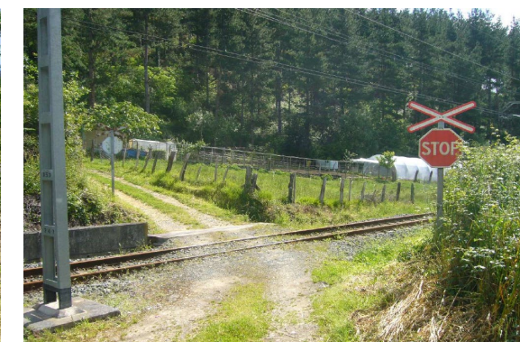
Margen izquierdo según sentido de kilometración ascendente
