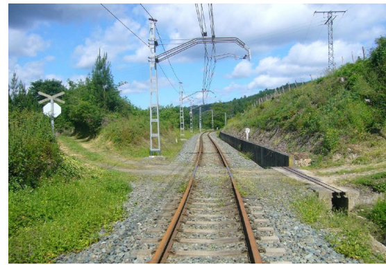
Imagen desde el eje de la vía en sentido decreciente de PK
