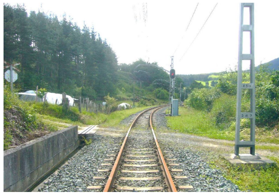
Imagen desde el eje de la vía en sentido creciente de PK
