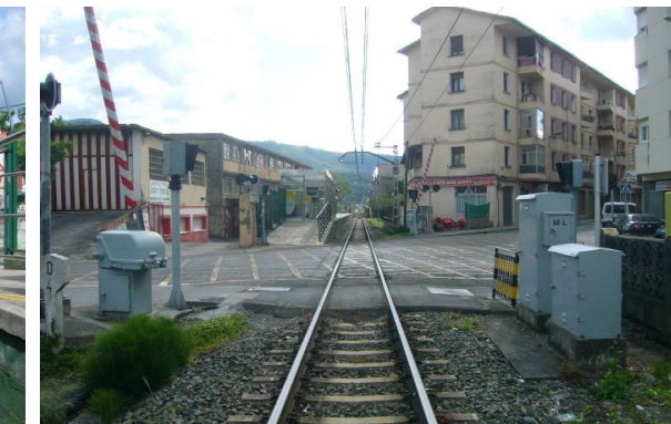
Imagen desde el eje de la vía sentido Bilbao
