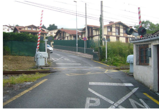
Margen izquierdo según sentido de kilometración ascendente
