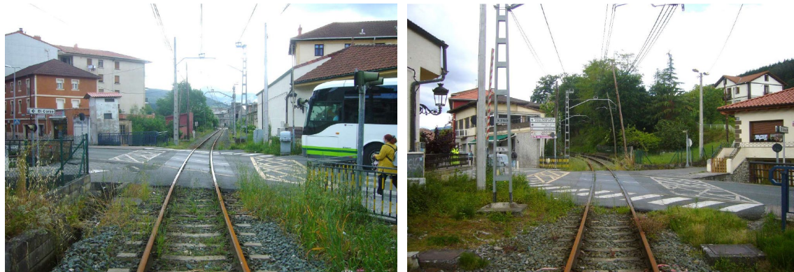
Imagen desde el eje de la vía en sentido creciente de PK
