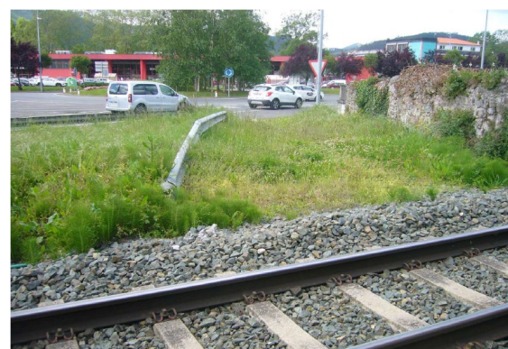
Margen izquierdo según sentido de kilometración ascendente
