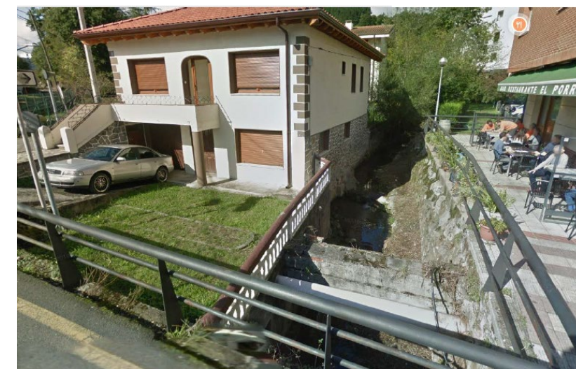
Cauce del arroyo Maruri aguas arriba del cruce con la Calle Maestra Consuelo. El edificio que se observa a la izquierda de la imagen será demolido.
