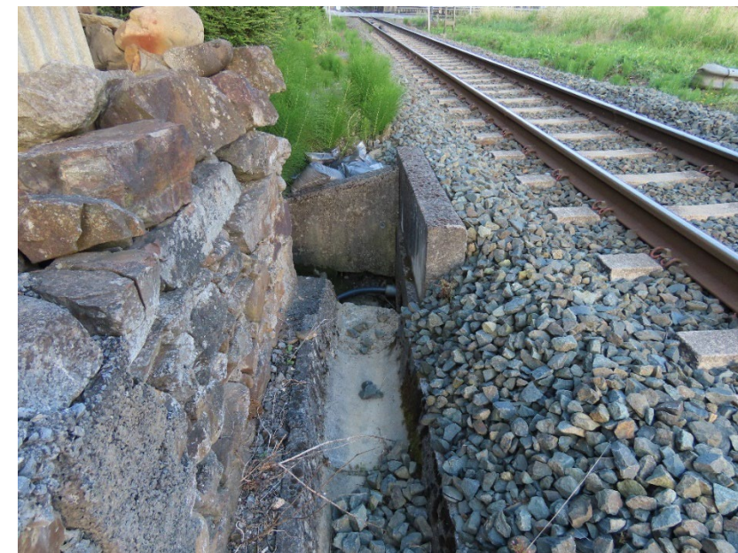
ODT existente en el PK 0+100 vía 790, entrada
