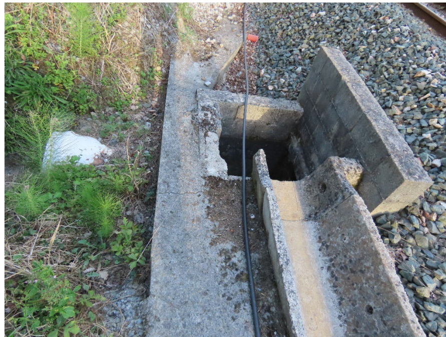
Arqueta de entrada Obra de drenaje existente PK 0+015 vía 780. Se adecuará a la nueva plataforma
