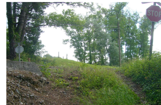
Margen izquierdo según sentido de kilometración ascendente
