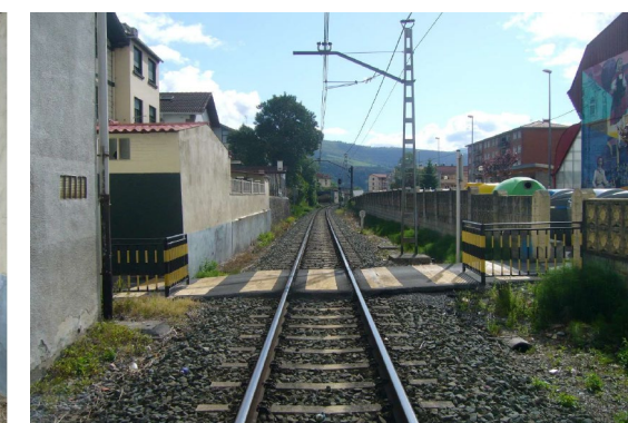
Imagen desde eje de vía en sentido decreciente de PK
