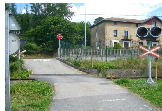
Margen derecho según sentido kilometración ascendente
