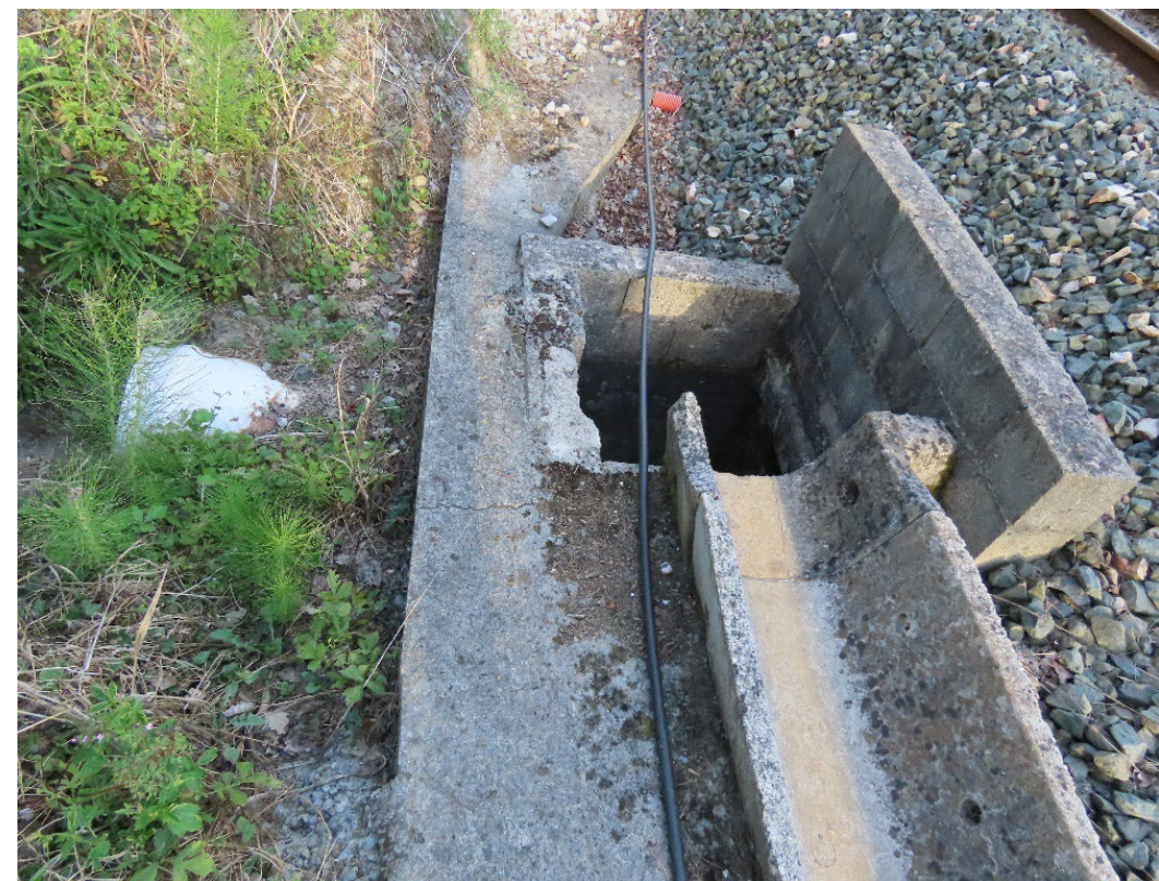
Arqueta de entrada Obra de drenaje existente PK 0+015 vía 780. Se adecuará a la nueva plataforma
