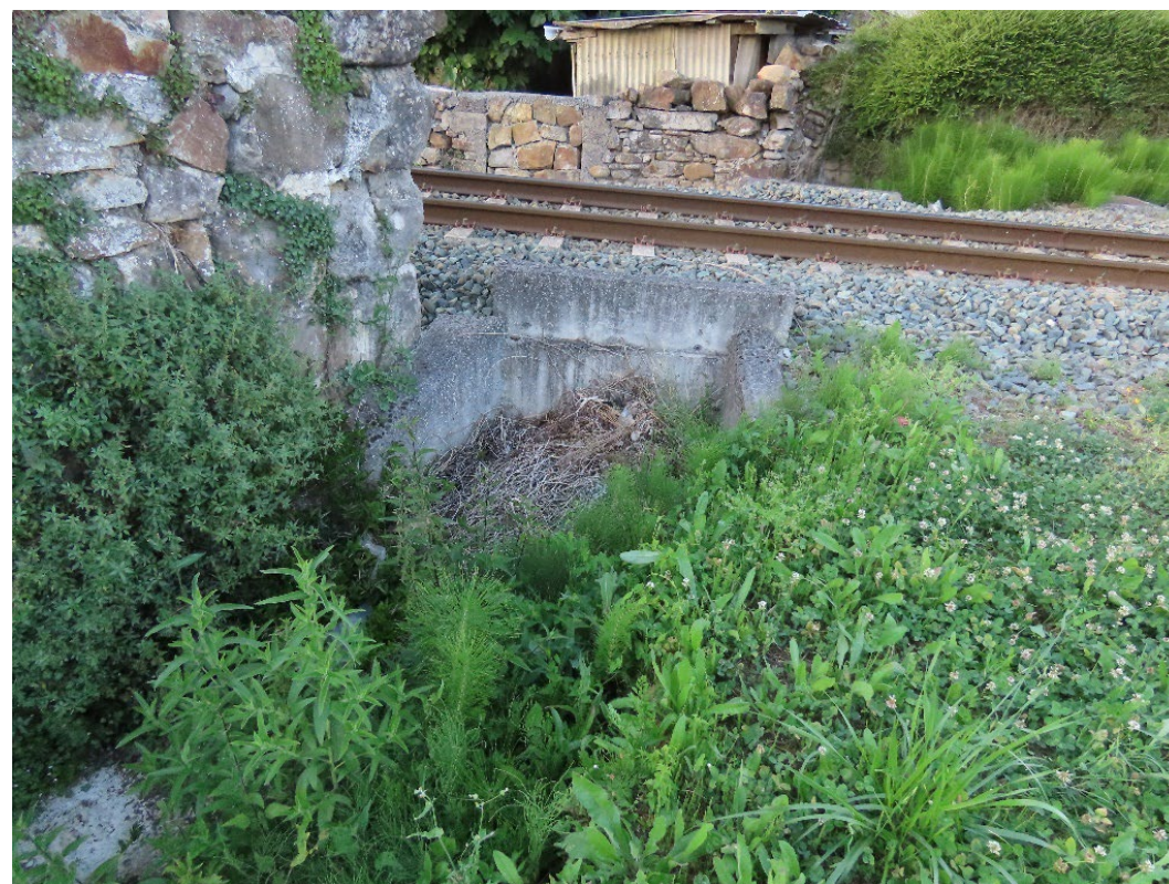
ODT existente en el PK 0+100 vía 790, salida
