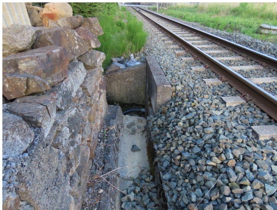
ODT existente en el PK 0+100 vía 790, entrada
