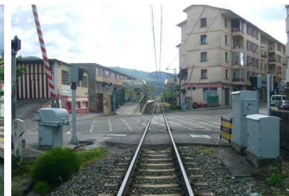
Imagen desde el eje de la vía sentido Bilbao
