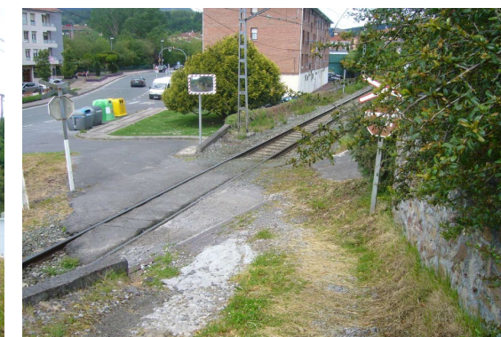
Margen izquierdo según sentido de kilometración ascendente
