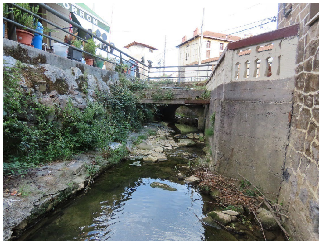
Cauce aguas arriba del puente sobre el río Maruri
