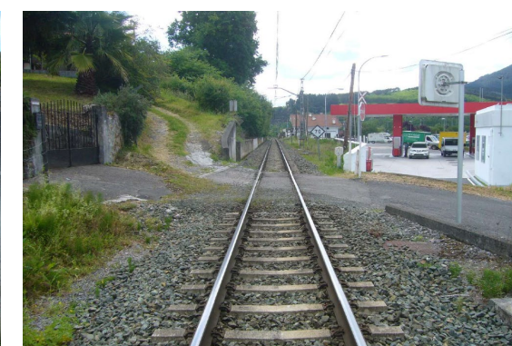
Imagen desde el eje de la vía en sentido decreciente de PK
