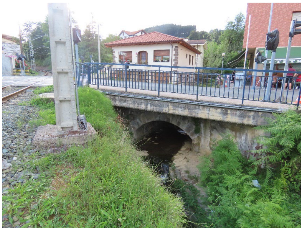
Puente sobre el arroyo Maruri en Calle Maestra Consuelo, que será objeto de ampliación
