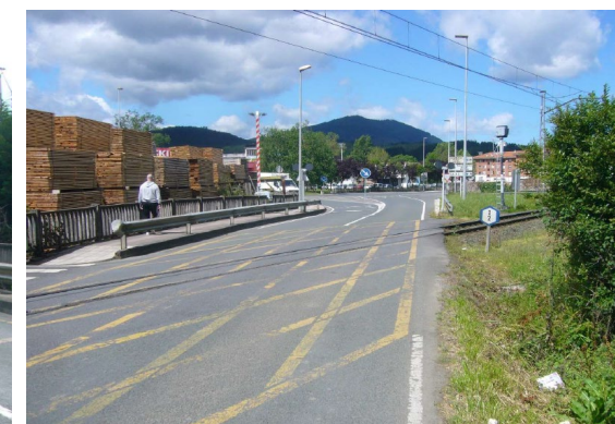
Margen izquierdo según sentido de kilometración ascendente
