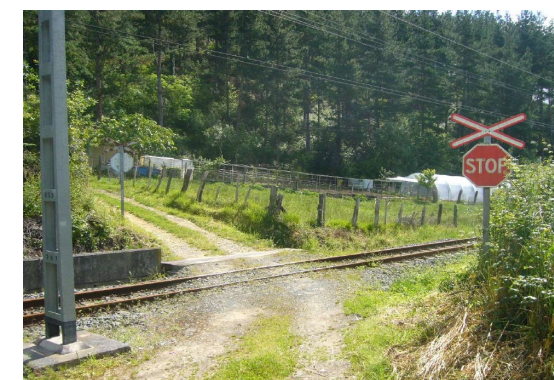
Margen izquierdo según sentido de kilometración ascendente
