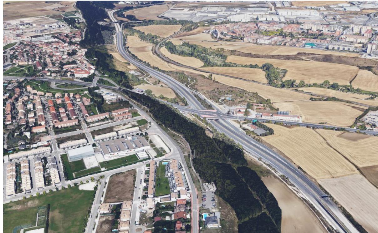
Figura 3.- Panorámica del entorno de Pamplona y Cizur en las inmediaciones del trazado de la autovía A-15.
