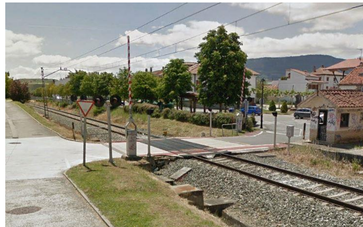
Figura 5.- Paso a nivel situado en el KM 171/204 de la línea 710 Castejón-Alsasua, a su paso por la localidad de Esquíroz.
