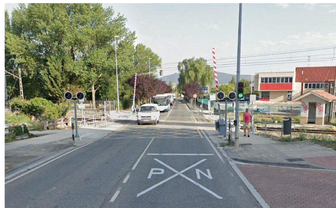
Figura 5.- Paso a nivel situado en el KM 183/975 de la línea 710 Castejón-Alsasua, en su cruce con la carretera NA-240-A, a su paso por Pamplona
