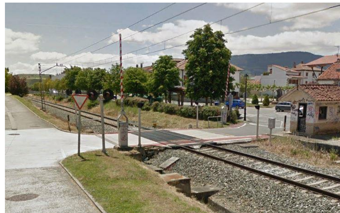
Figura 4.- Paso a nivel situado en el KM 171/204 de la línea 710 Castejón-Alsasua, a su paso por la localidad de Esquíroz.
