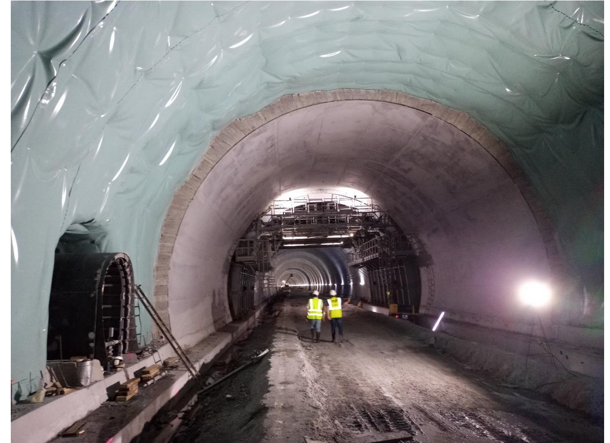
Figura 29: Instalación de impermeabilización y revestimiento
