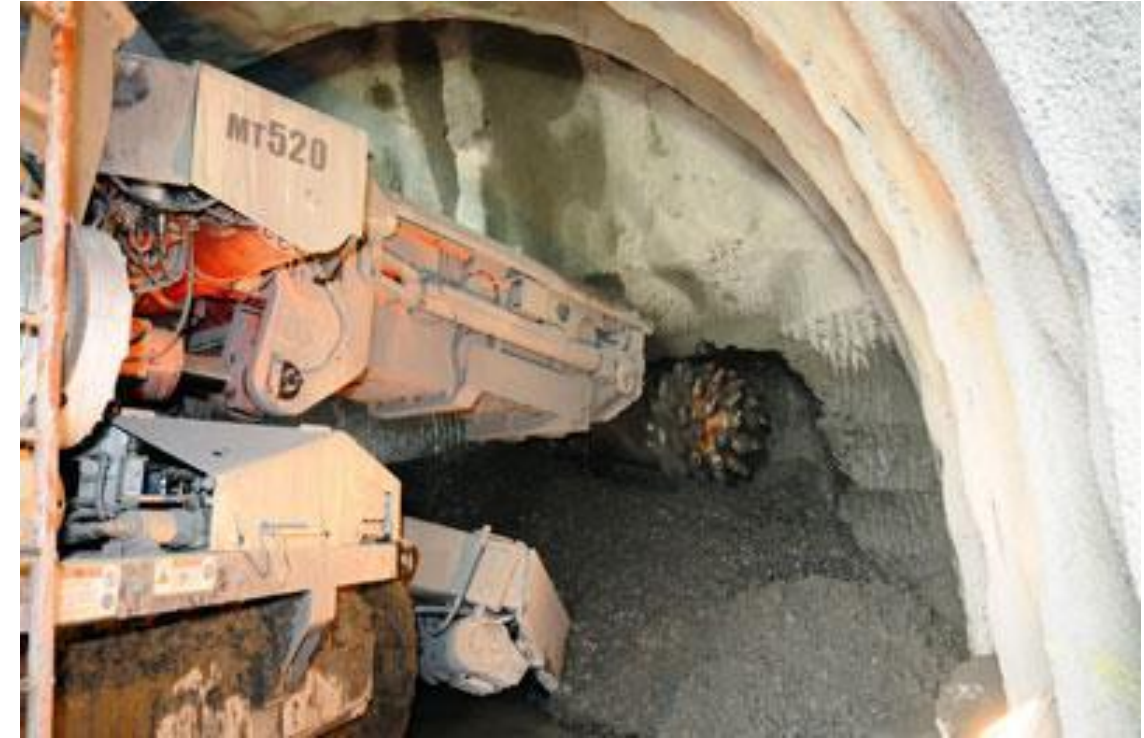
Figura 24: Máquina rozadora para túneles (excavación mecánica)
