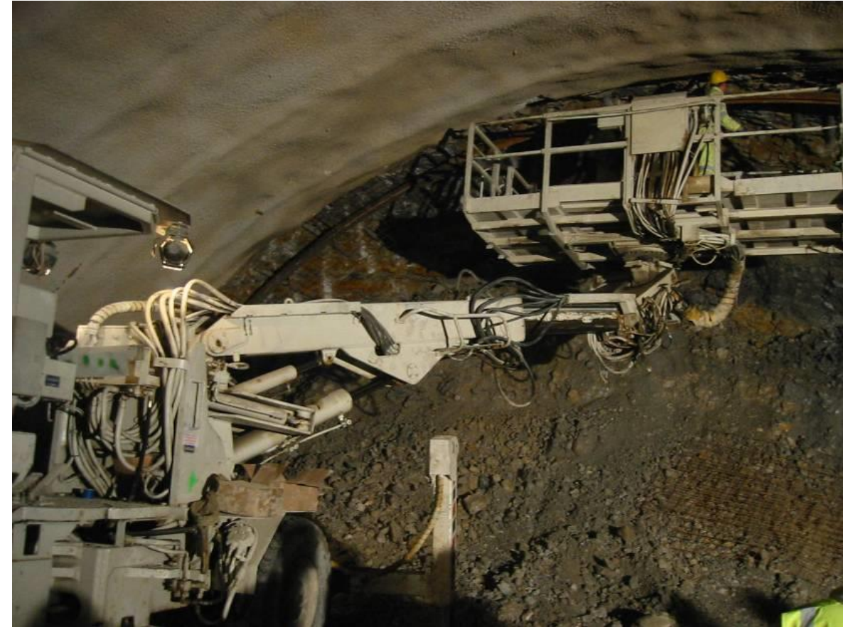
Figura 27: Plataforma de elevación hidráulica para colocación de cerchas y mallazo
