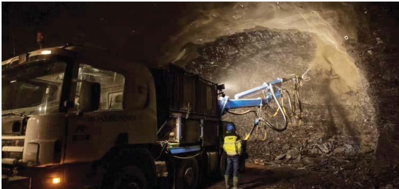
Figura 26: Equipo de proyección de hormigón colocando la capa de sellado
