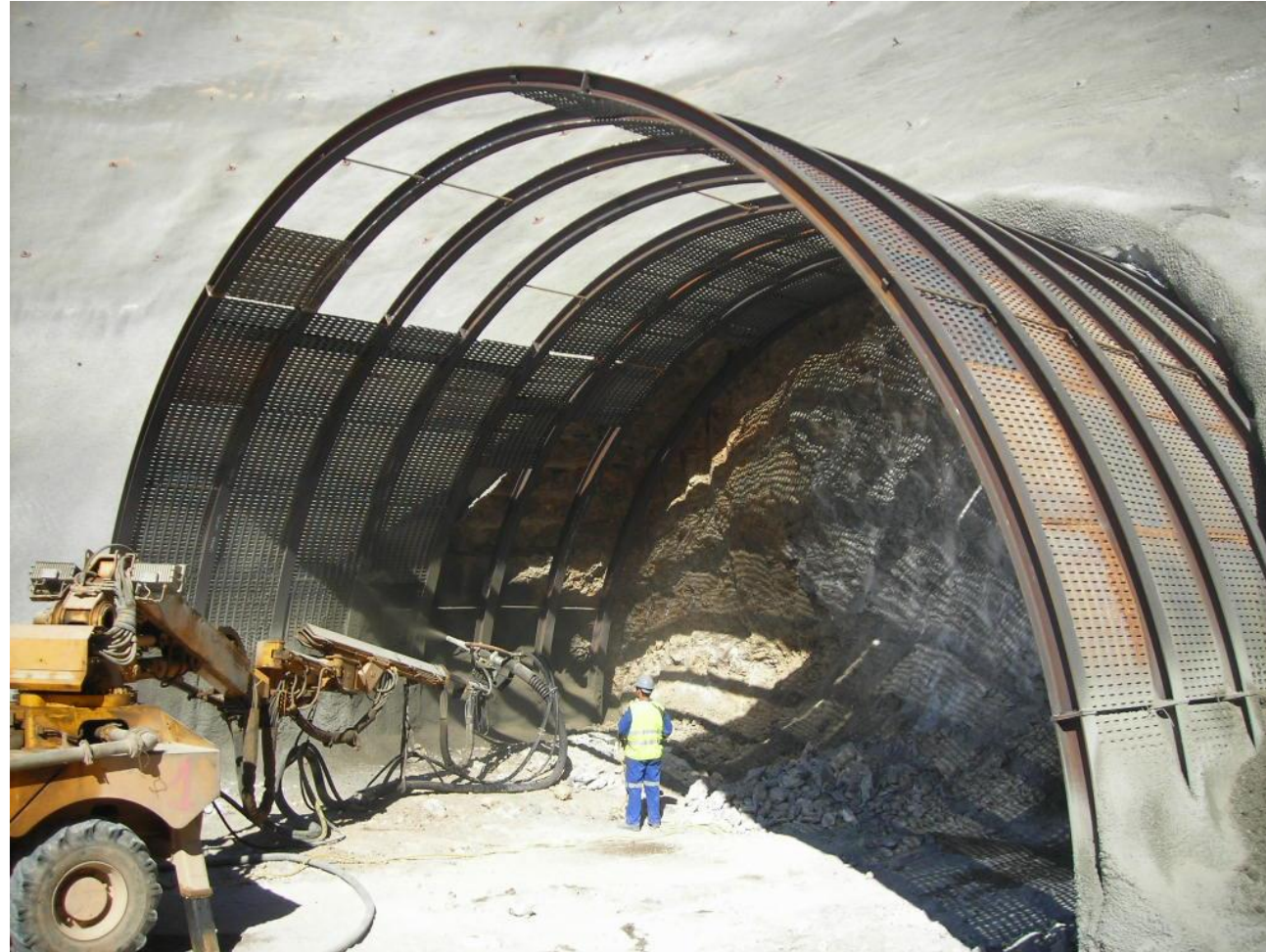
Figura 23: terminación de la visera de protección
