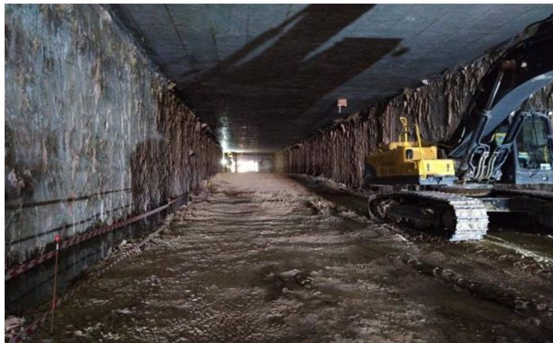
Figura 31: Trabajos bajo losa en un túnel entre pantallas
