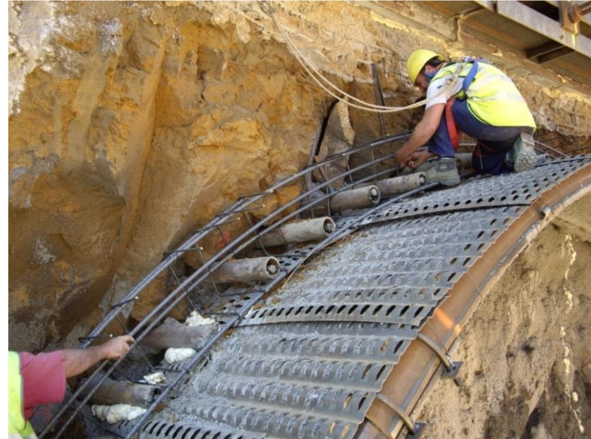
Figura 22: Colocación de visera de protección en emboquille
