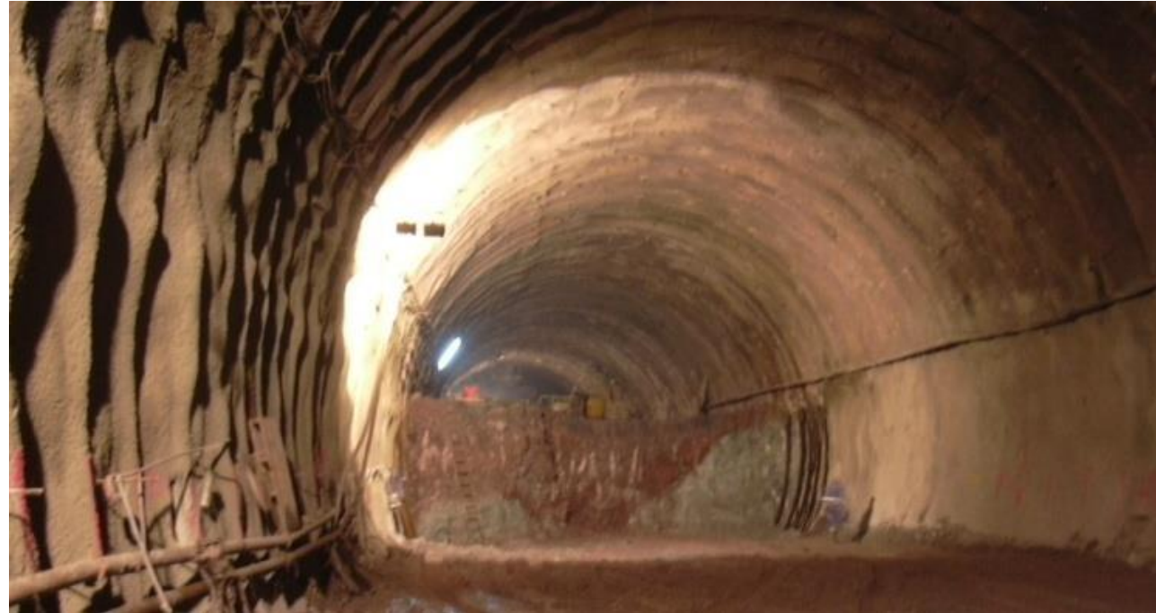
Figura 28: Vista del frente de excavación de la destroza de un túnel
