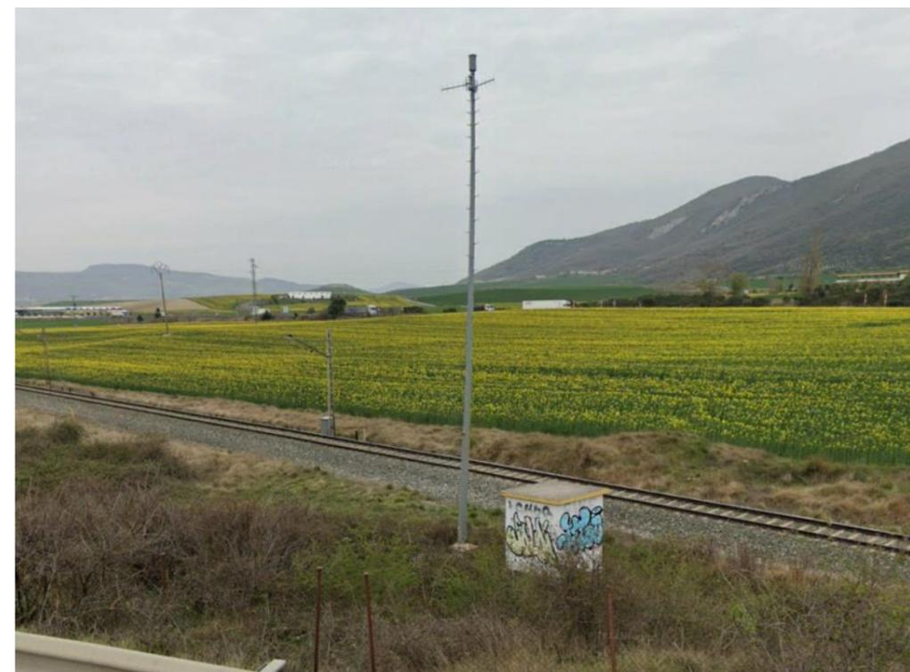
Figura 5. Puesto de Tren Tierra con antena de 15 metros ubicado en el PK 161/975
