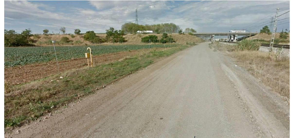
Figura 9. Disposición de respiradero del gasoducto en la zona del cruce bajo la línea de ferrocarril
