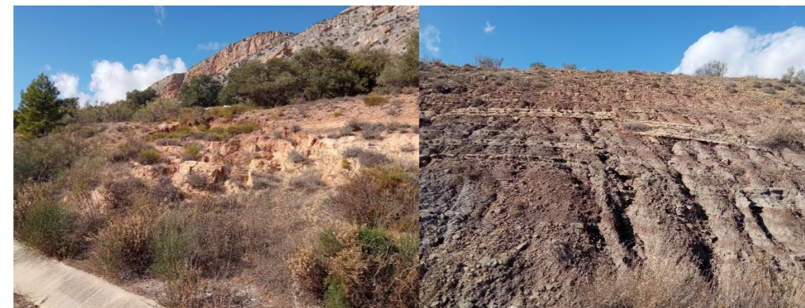
Deslizamientos y cárcavas en materiales cohesivos.
