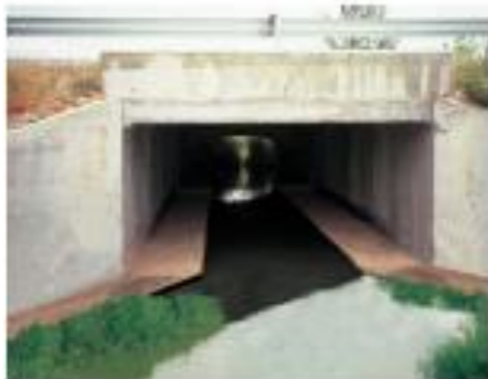
Fuente: Drenaje adaptado para animales terrestres. "Prescripciones Técnicas para el Diseño de Pasos de Fauna y Vallados Perimetrales".
