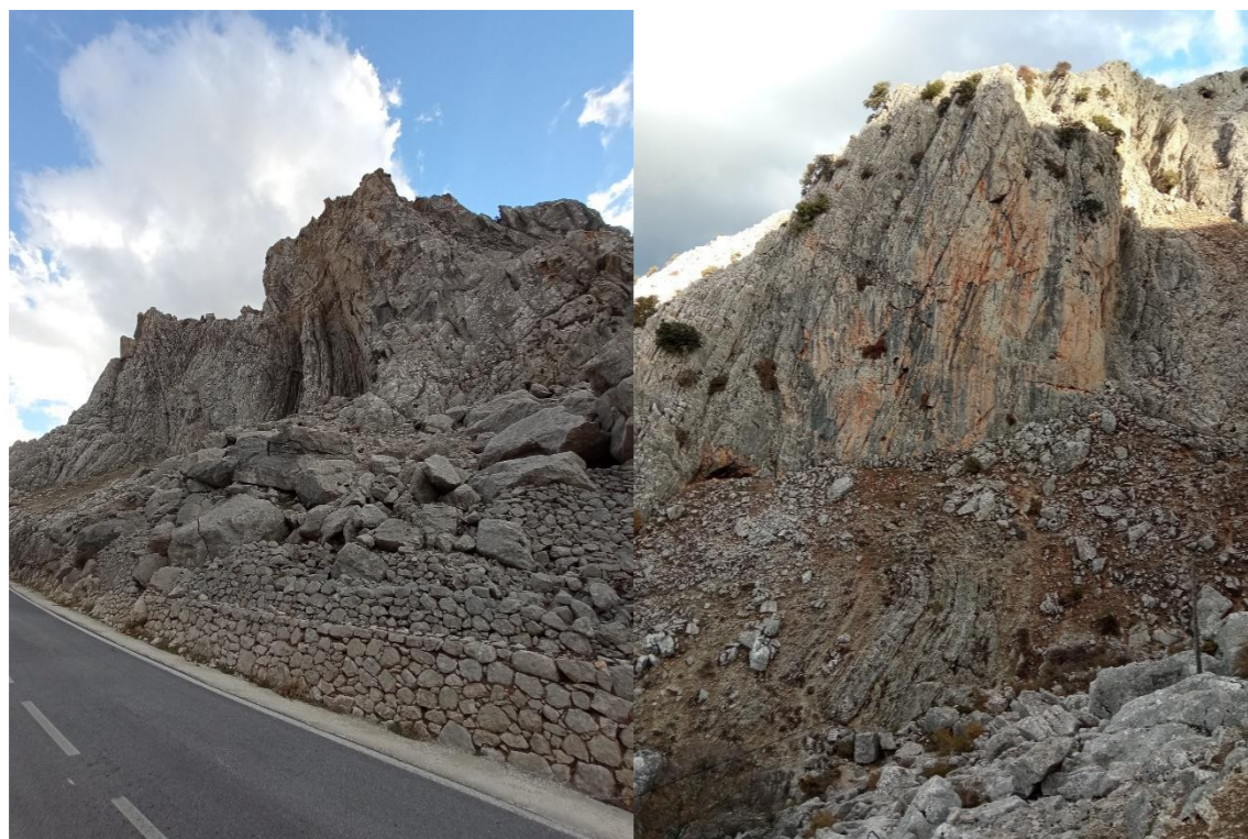
Desprendimientos a favor de los planos de estratificación y fracturación.
