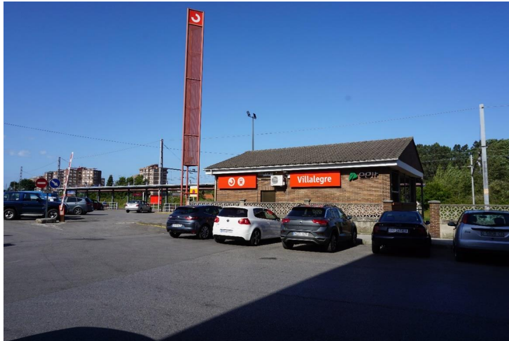
Foto 1. Actual Estación de Villalegre.
