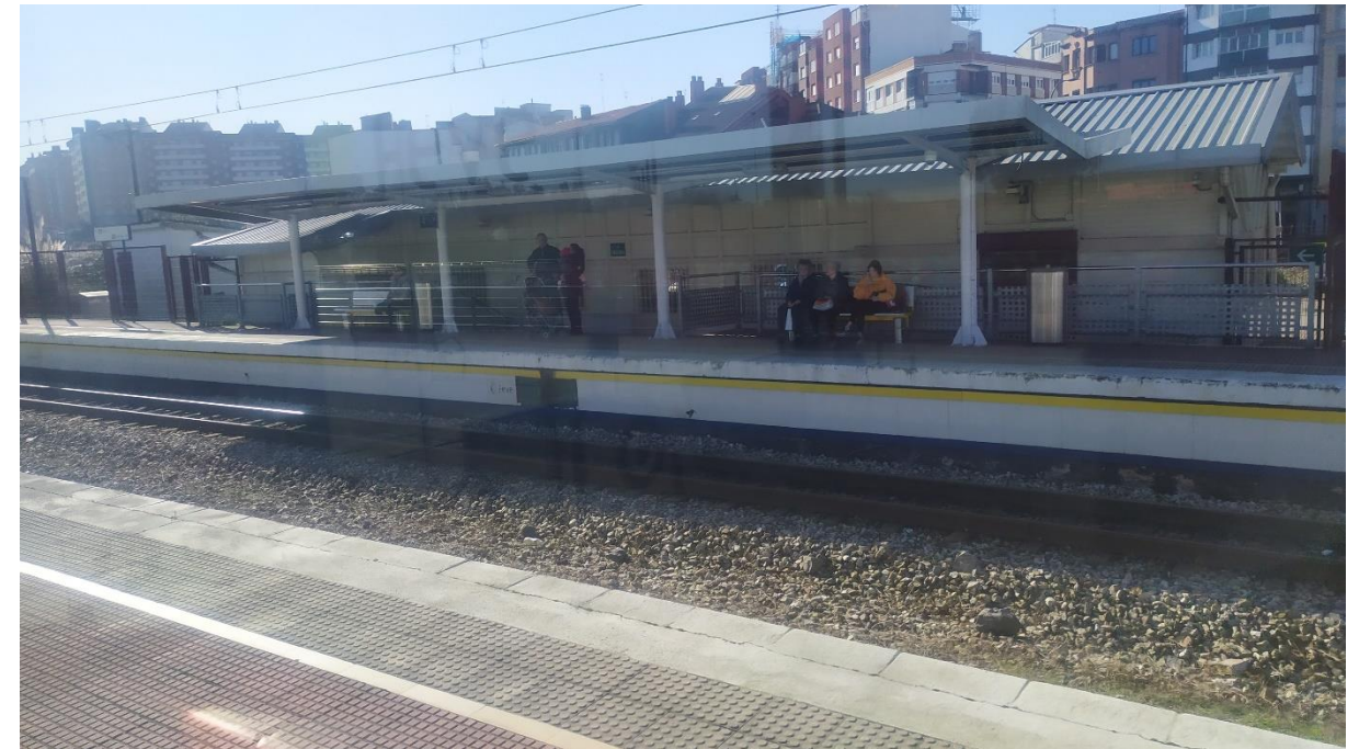
Foto 34. Apeadero de Avilés en ancho métrico. Zona de andenes.
