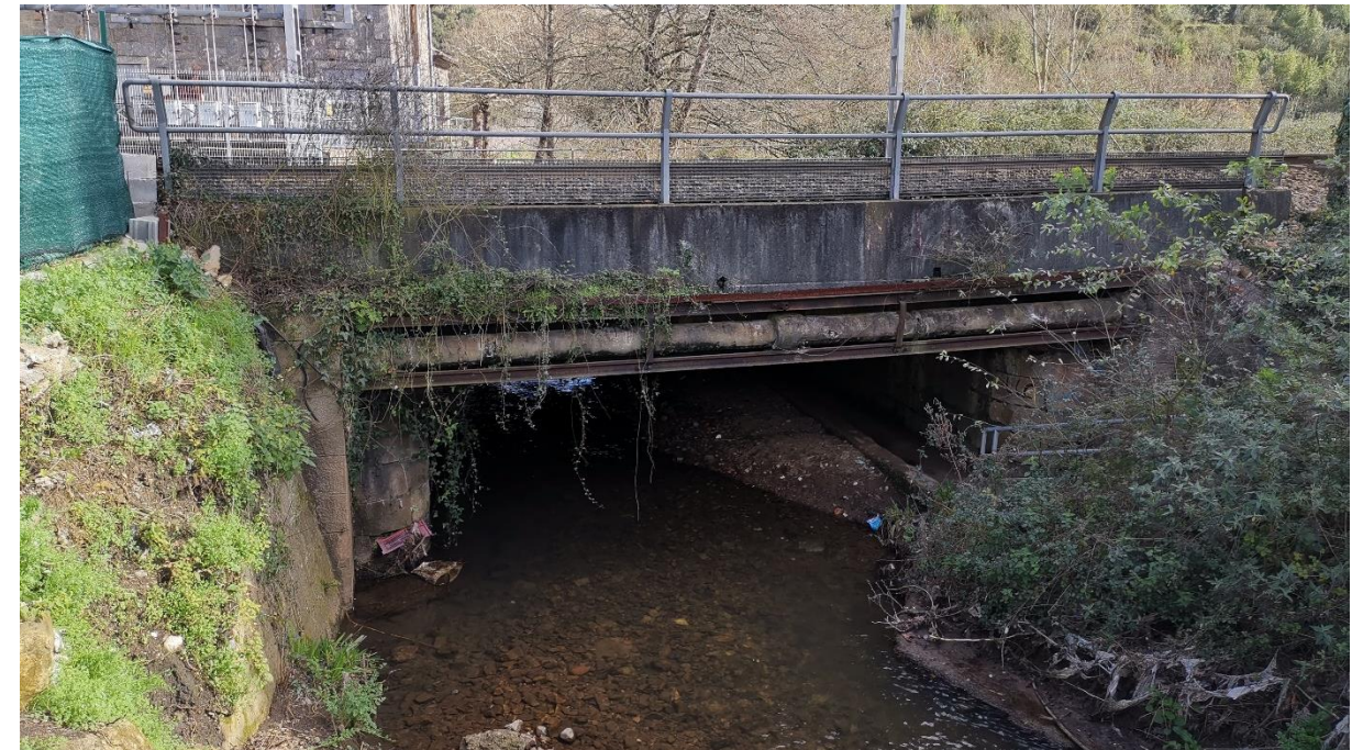
Foto 2. Cruce del río Arlos bajo la Estación de Villalegre.
