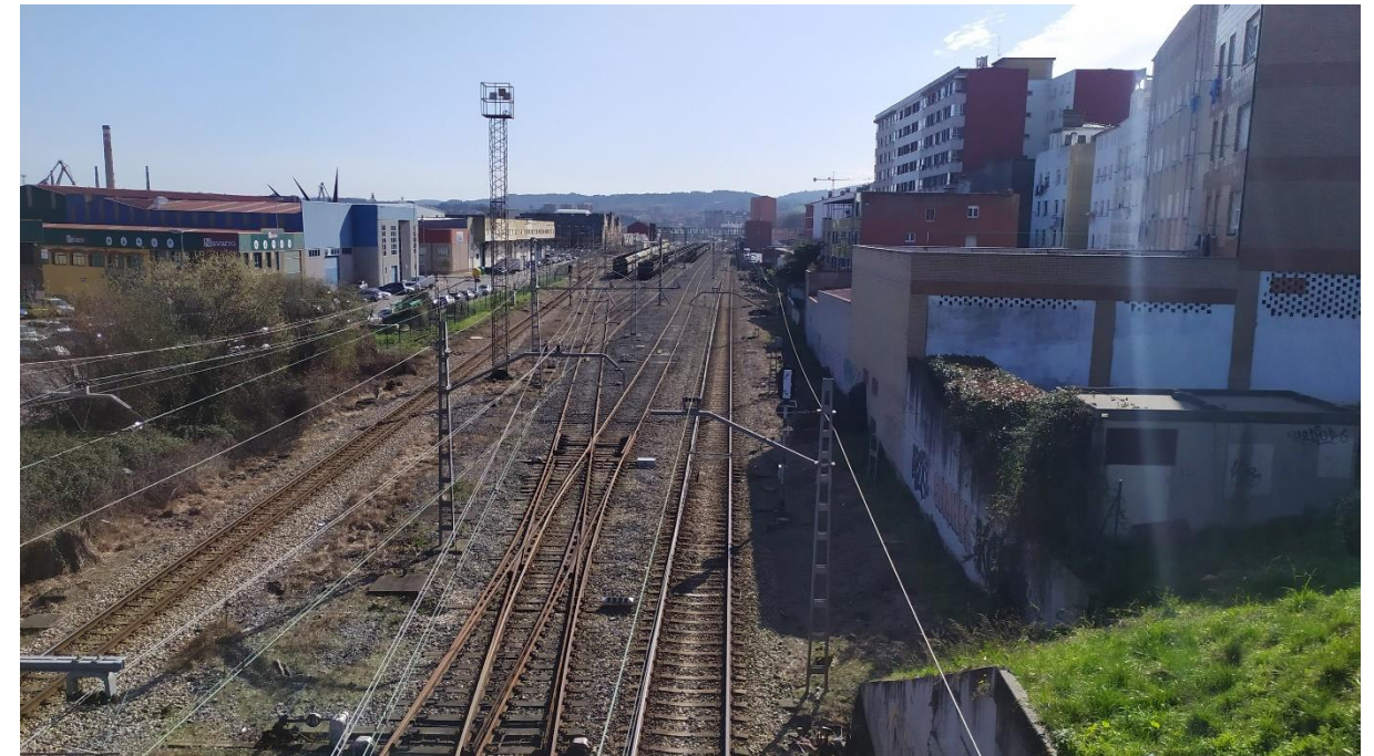
Foto 46. Vista hacia el sur de los corredores de ancho métrico e ibérico. Foto obtenida desde el paso superior de La Travesía de la industria.
