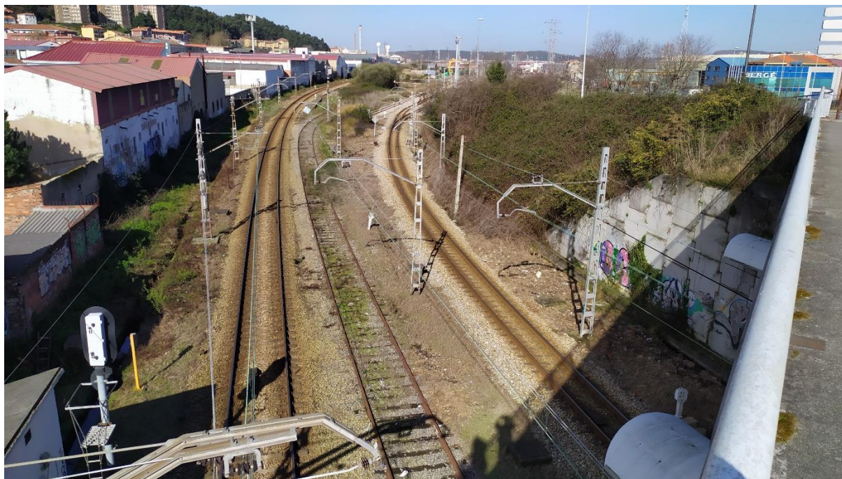
Foto 47. Vista hacia el norte de los corredores de ancho métrico e ibérico. Foto obtenida desde el paso superior de La Travesía de la industria.
