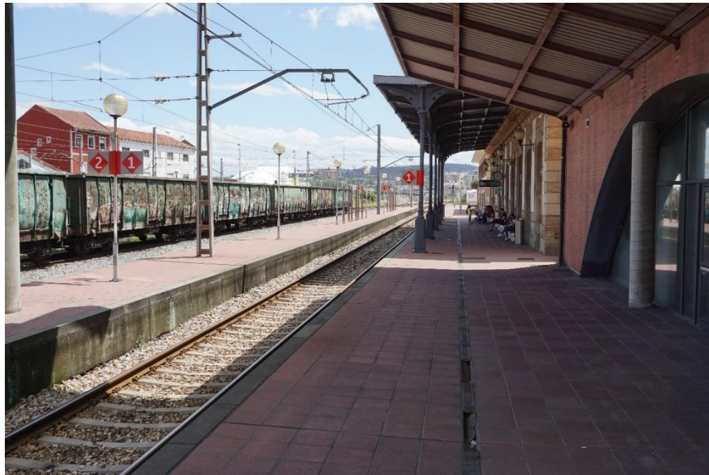
Foto 45. Zona de andenes de la Estación de Avilés.
