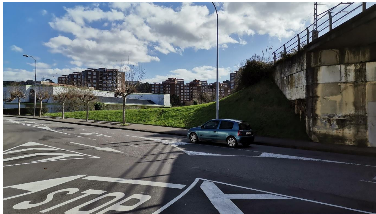
Foto 13. Cruce de la Calle Avilés bajo el corredor ferroviario de ancho ibérico. Vista hacia el norte de la vertiente este del corredor ferroviario.
