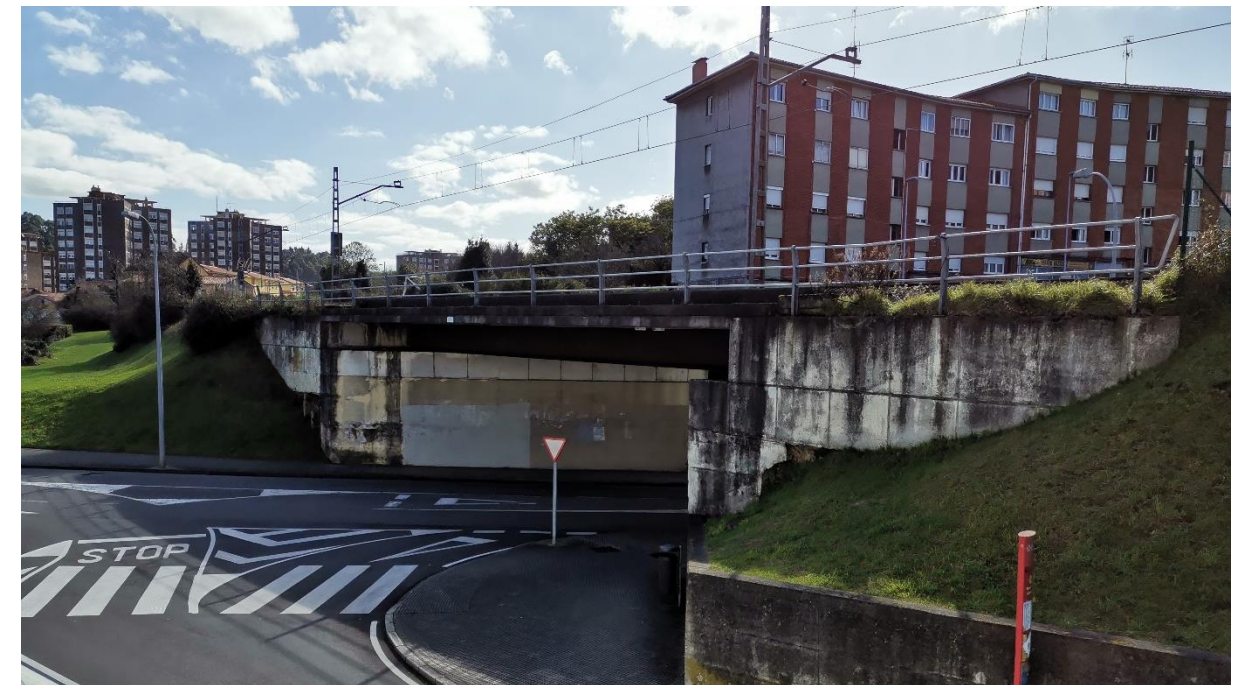
Foto 14. Cruce de la Calle Avilés bajo el corredor ferroviario de ancho ibérico.
