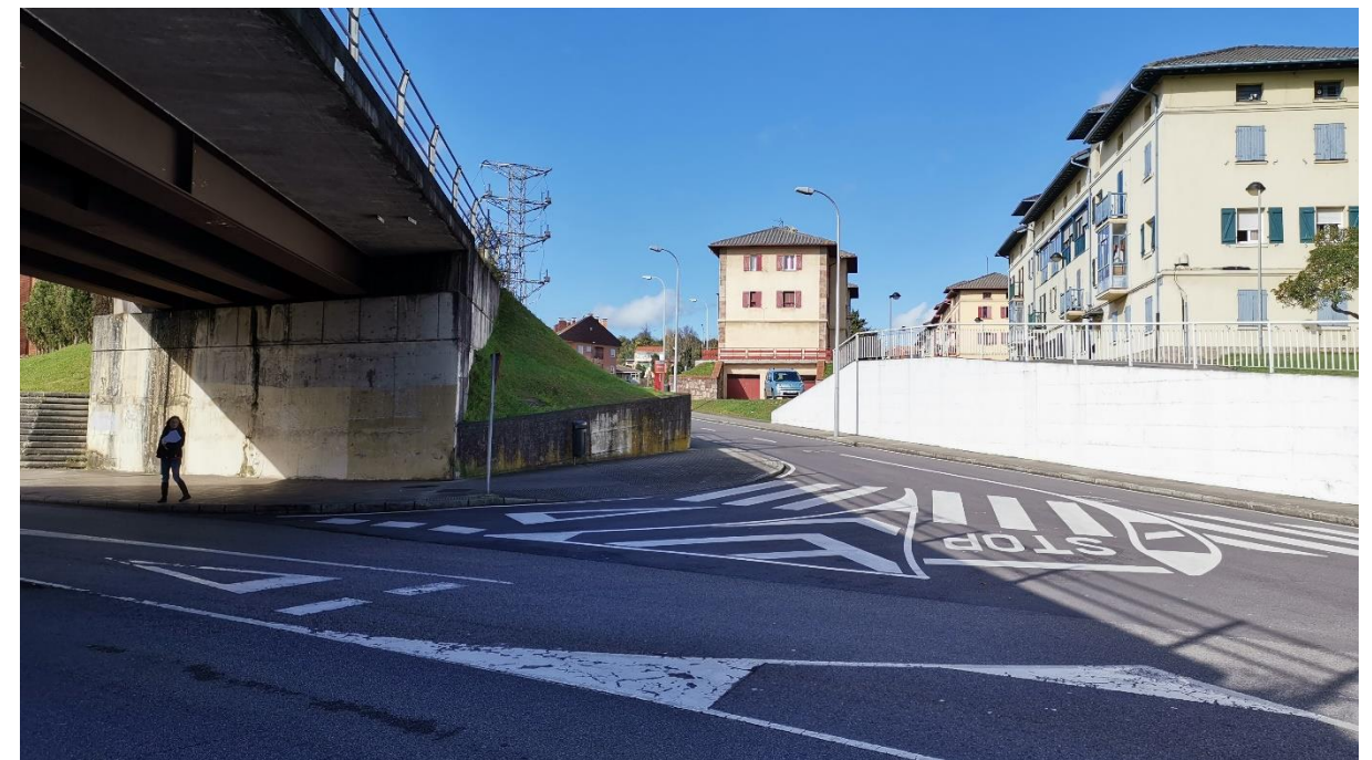
Foto 12. Cruce de la Calle Avilés bajo el corredor ferroviario de ancho ibérico. Vista hacia el sur de la vertiente este del corredor ferroviario.
