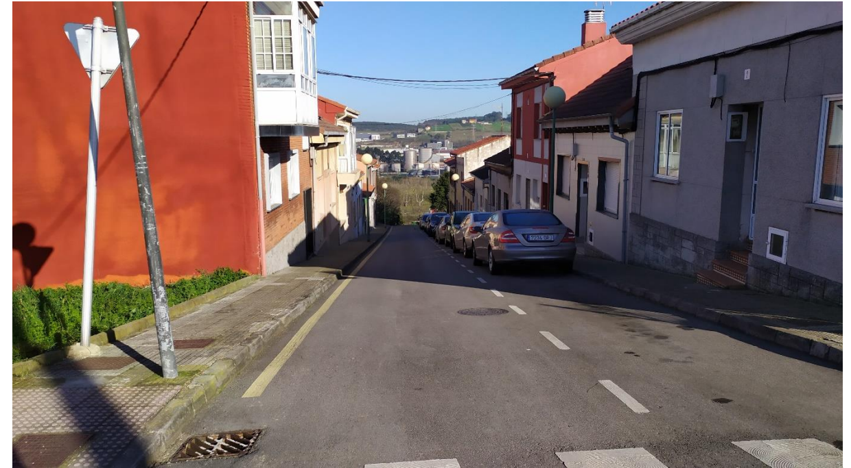
Foto 22. Viviendas situadas sobre la salida norte del futuro túnel del Bustiello.
