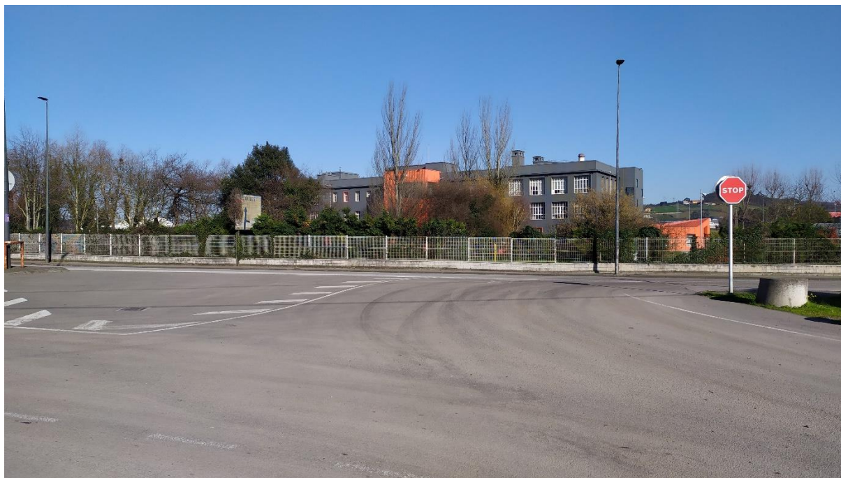
Foto 23. Edificio de Arcelormittal.
