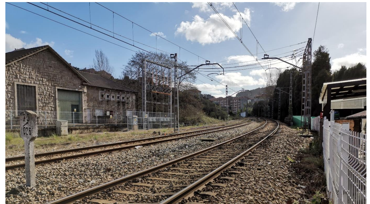
Foto 4. Subestación eléctrica ubicada en la Estación de Villalegre.
