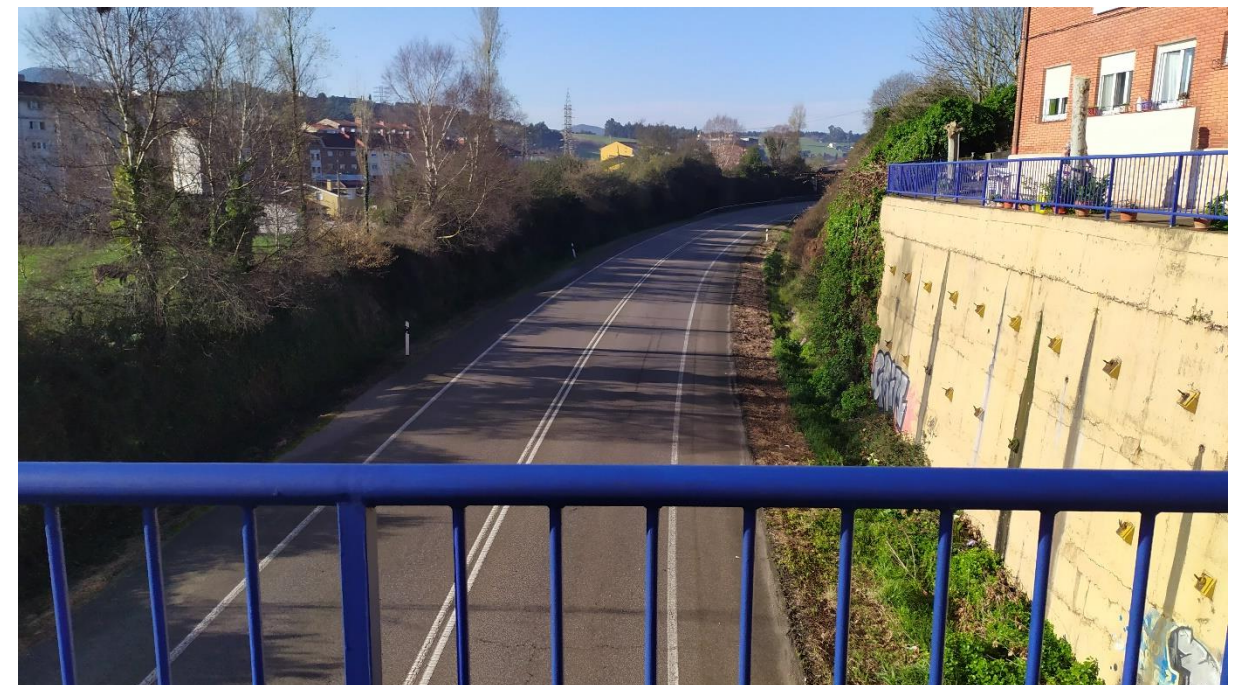
Foto 20 Vista hacia el oeste de la N-632.
