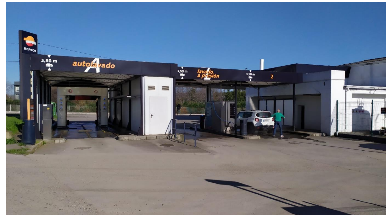
Foto 24 Gasolinera afectada por las futuras obras ferroviarias.
