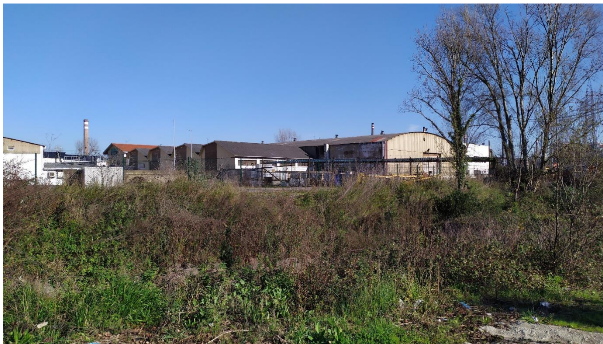
Foto 27. Edificaciones situadas cerca de la zona de la futura Estación Intermodal.
