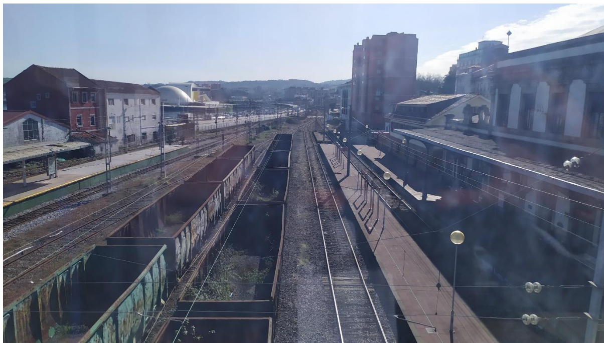
Foto 43. Vista hacia el sur de los corredores de ancho métrico e ibérico. Foto obtenida desde la pasarela peatonal de acceso al andén de ancho métrico.
