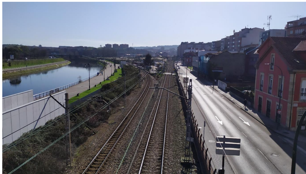
Foto 35. Vista hacia el sur de los corredores de ancho métrico e ibérico dentro del entramado urbano de la ciudad de Avilés. Foto obtenida desde la pasarela peatonal "La grapa".
