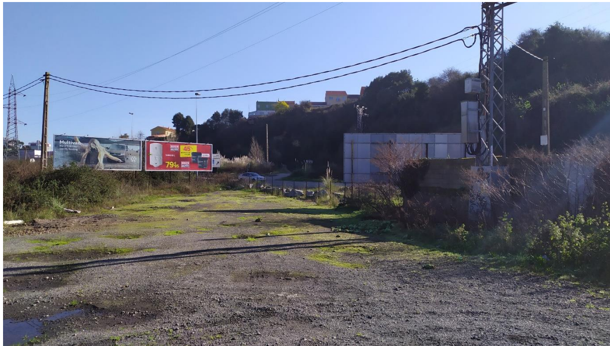
Foto 25. Vista del emboquille norte del futuro túnel del Bustiello.
