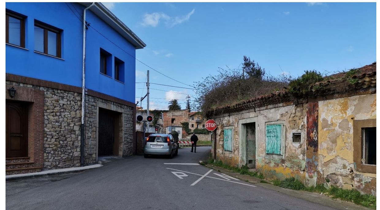
Foto 8. Viviendas situadas junto al paso a nivel de la Plaza Castañedo.
