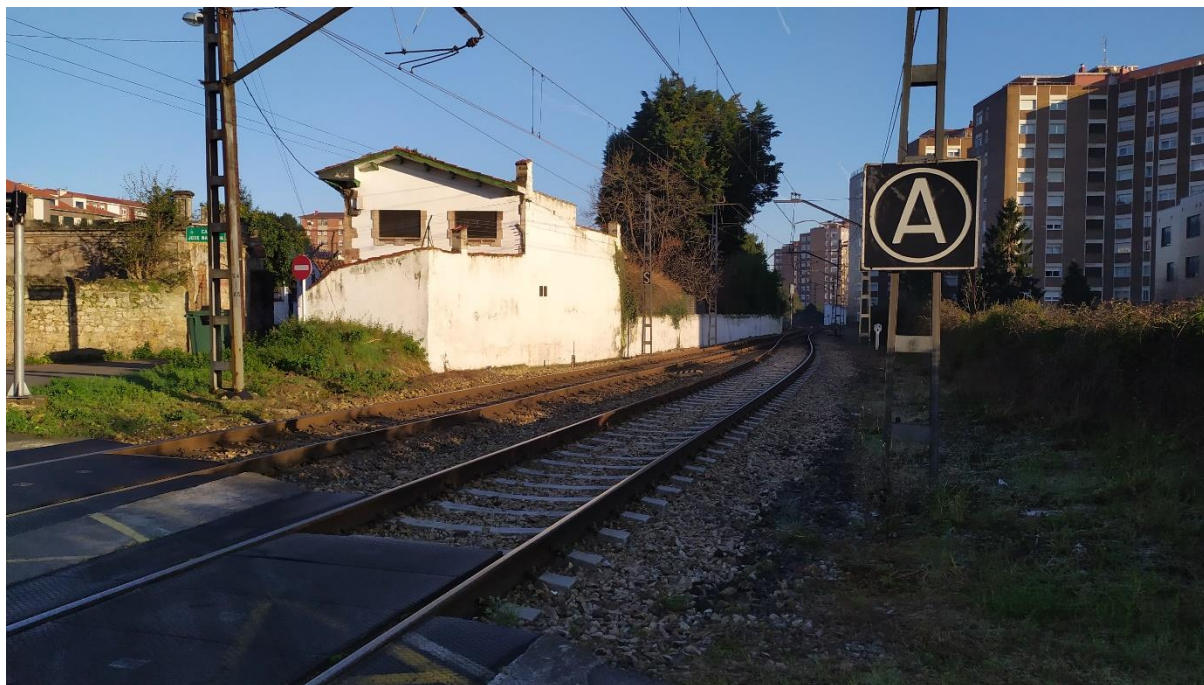
Foto 7. Edificio de viviendas habitadas situadas junto al corredor de ancho ibérico.
