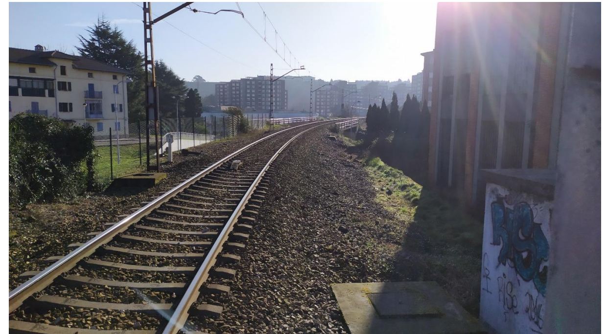
Foto 18. Vista del cruce del ferrocarril sobre la Calle Avilés desde el Apeadero de La Rocica.
