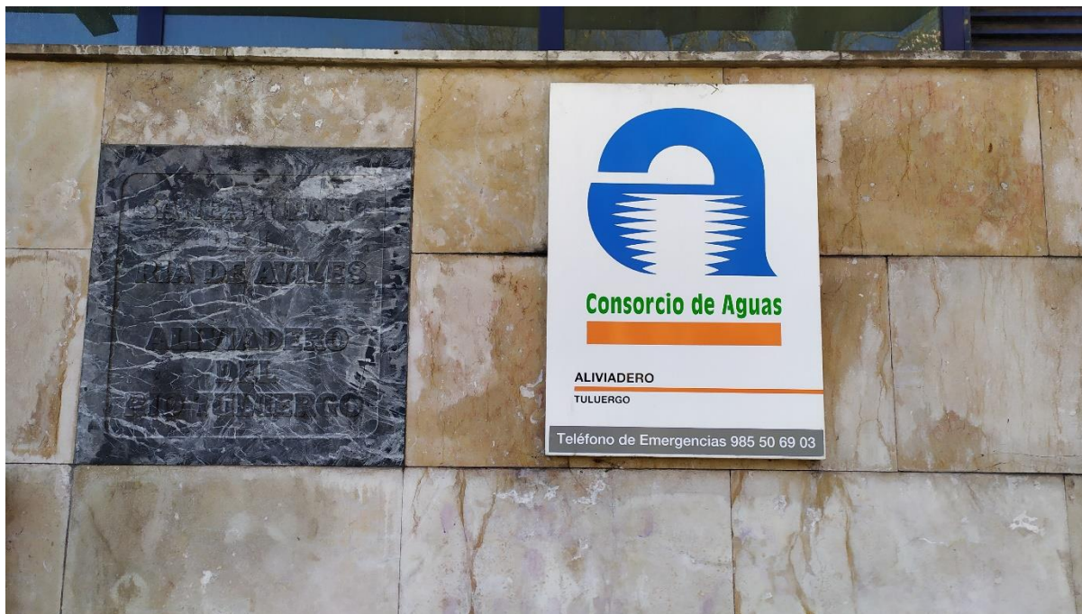
Foto 39. Aliviadero del río Tuluergo.
