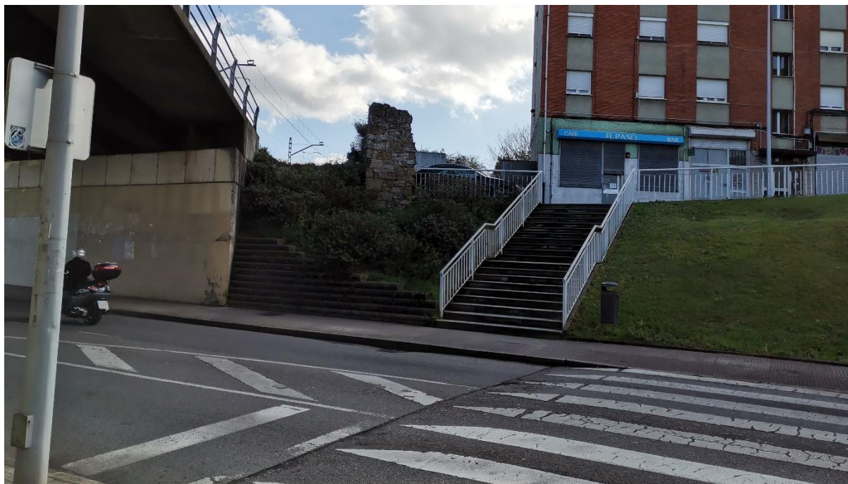
Foto 11. Cruce de la Calle Avilés bajo el corredor ferroviario de ancho ibérico. Vista hacia el norte de la vertiente oeste del corredor ferroviario.
