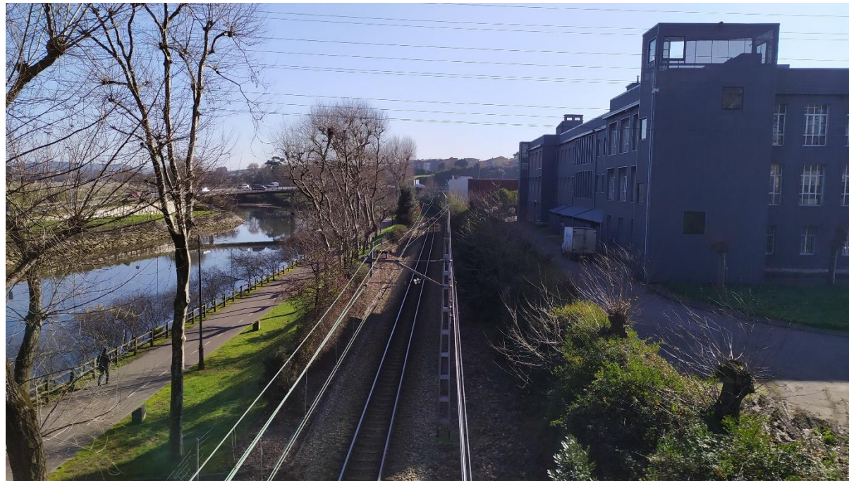
Foto 29. Vista del edificio de Arcelormittal y del corredor de ancho métrico desde la AS-238. Vista hacia el norte.
