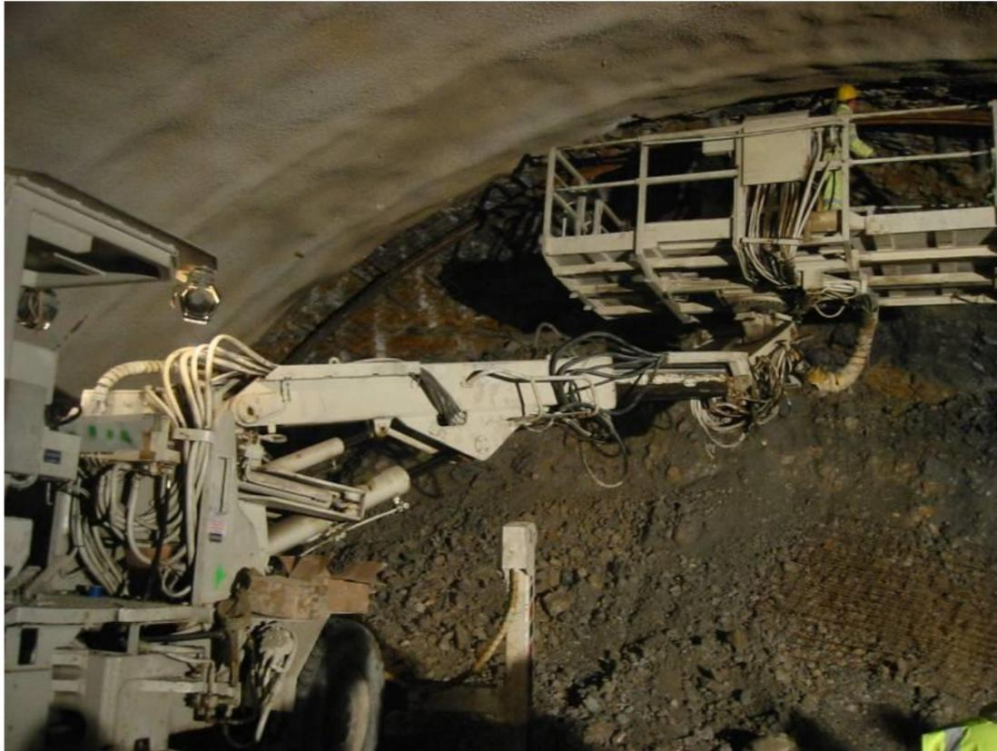
**Ilustración 22: Plataforma de elevación hidráulica para colocación de cerchas y mallazo**
