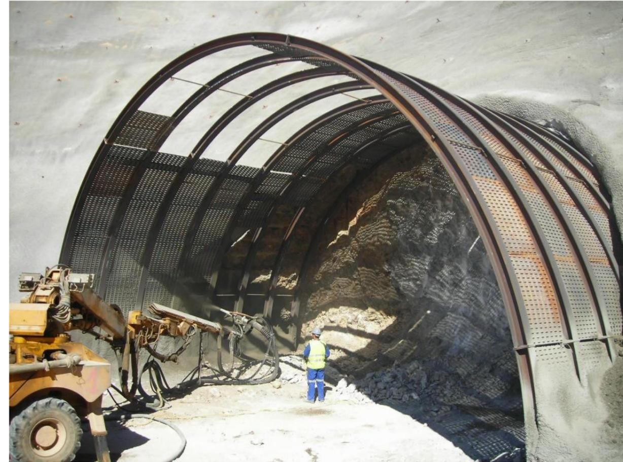
**Ilustración 18: terminación de la visera de protección**
