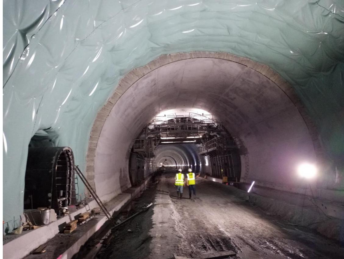
**Ilustración 24: Instalación de impermeabilización y revestimiento**
