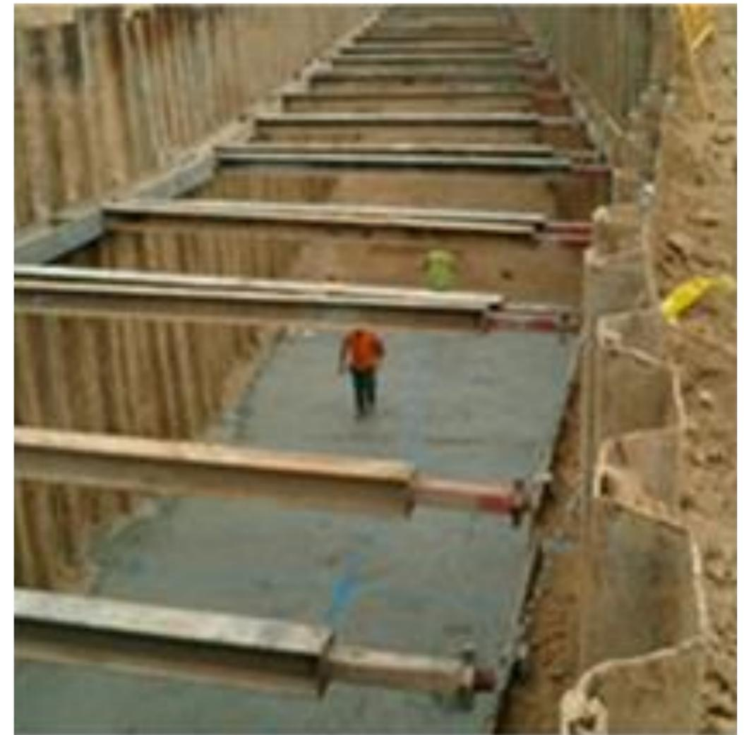
**Ilustración 25: Zanja tablestacada**
