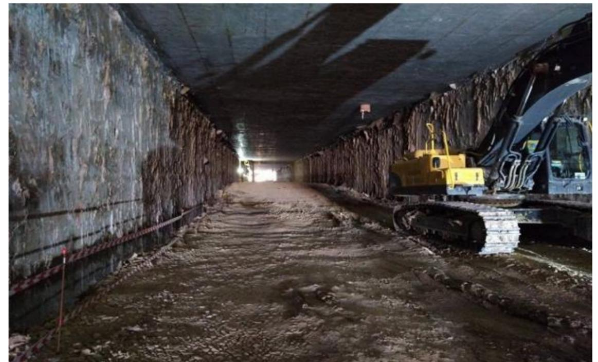
Ilustración 28: Trabajos bajo losa en un túnel entre pantallas
