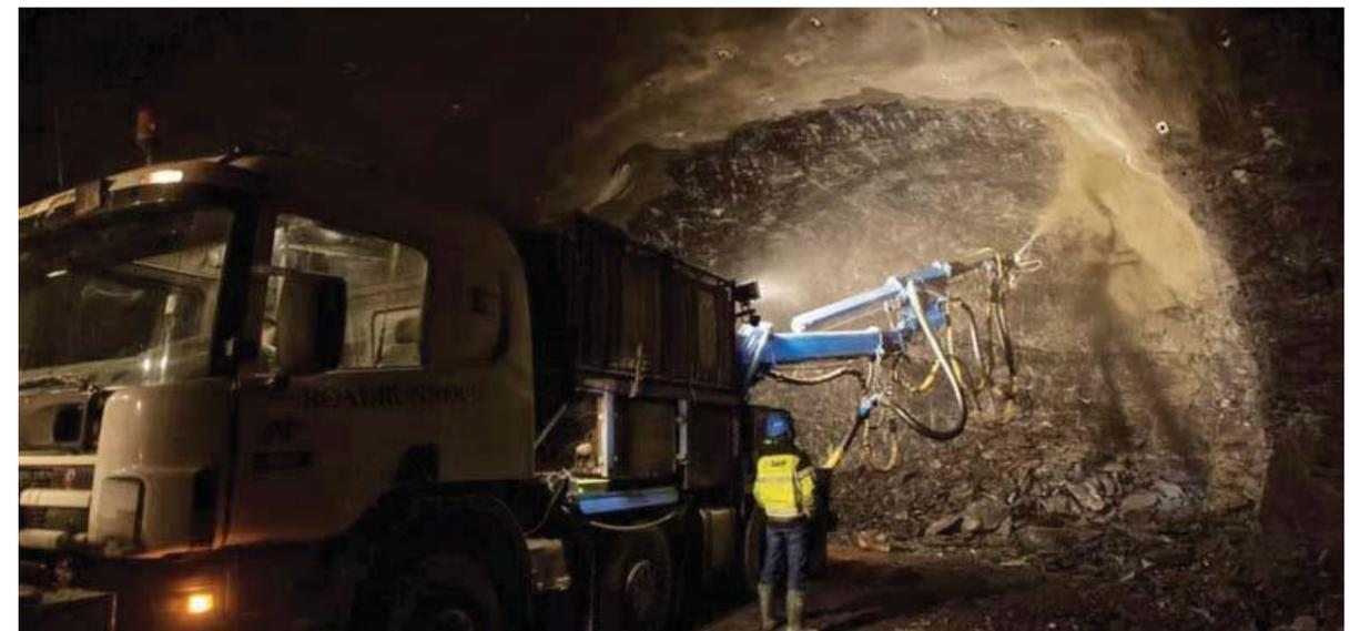
**Ilustración 21: Equipo de proyección de hormigón colocando la capa de sellado**
