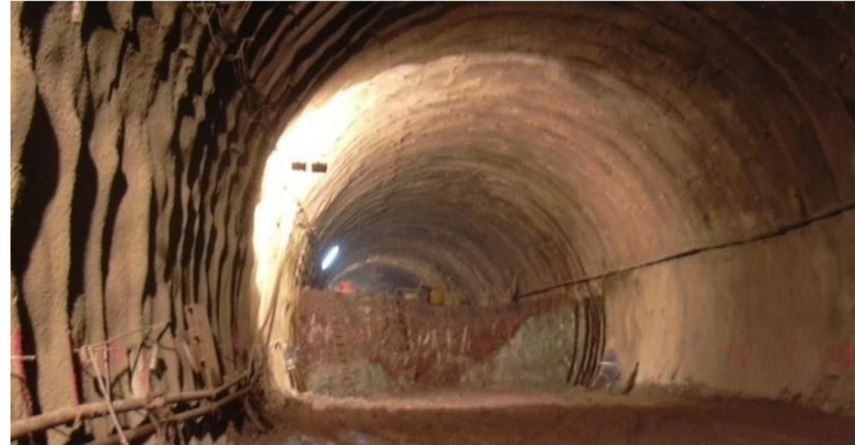
**Ilustración 23: Vista del frente de excavación de la destroza de un túnel**
