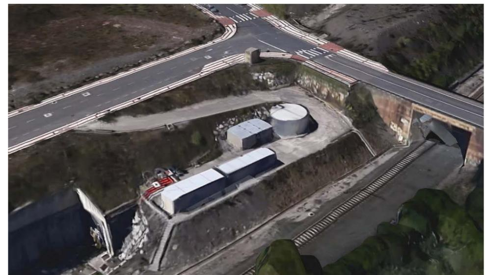
La visita al interior de la obra ejecutada que discurre entre las instalaciones del Puerto de Bilbao y Ortuella permitió comprobar que, si bien la mayor parte del trazado se ha ejecutado en su totalidad (incluyendo instalaciones, superestructura completa de vía y catenaria, ...) el tramo final de bifurcación cuenta tan solo
