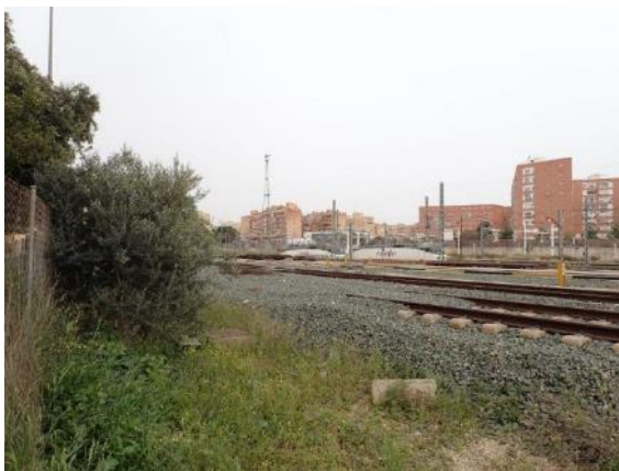
Figura 65: Vista general del tramo final construido correspondiente a la Alternativa 1, Pk 2+600.
