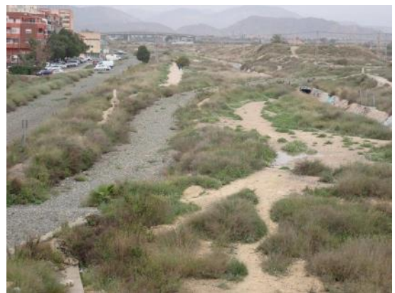
Figura 64: Vista general del tramo soterrado construido correspondiente a la Alternativa 1 variante Este, Pk 2+200.
