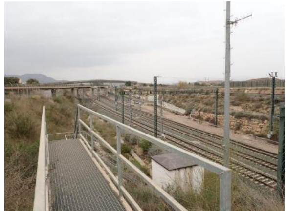
Figura 62: Vista general del tramo construido correspondiente a la Alternativa 2.1-2.2 Pk 8+100.
