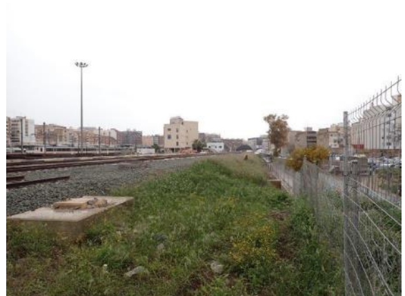
Figura 66: Tramo final del tramo construido correspondiente a la Alternativa 1, Pk 2+950.
