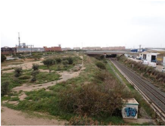
Figura 61: Vista general del tramo construido correspondiente a la Alternativa 2.1-2.2, Pk 7+600.
