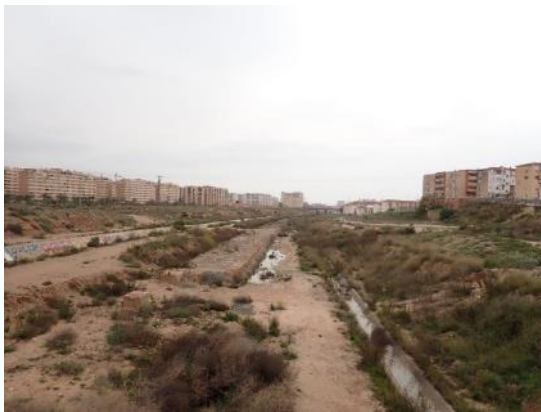
Figura 63: Vista general del tramo soterrado construido correspondiente a la Alternativa 1 variante Este, Pk 1+800.
