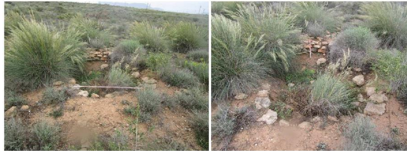
F51. Pk 5+955 estructura circular
