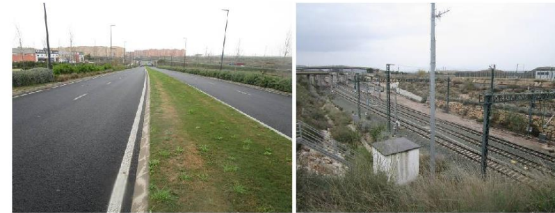
F55. Tramo urbano en el Pk 7+000 al sur
