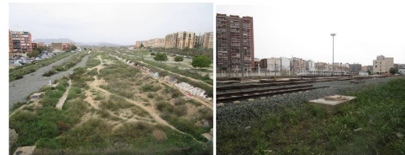
F57. Corredor ferroviario actual Pk 8+600 al oeste
