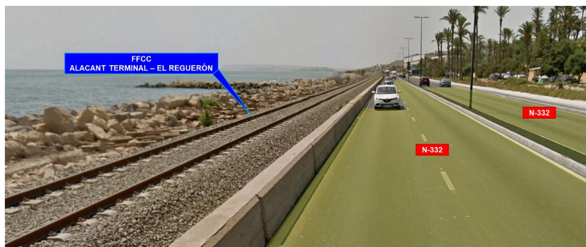
Ilustración 6. Infraestructura de la línea 336 en su tramo paralelo a la N-340.
