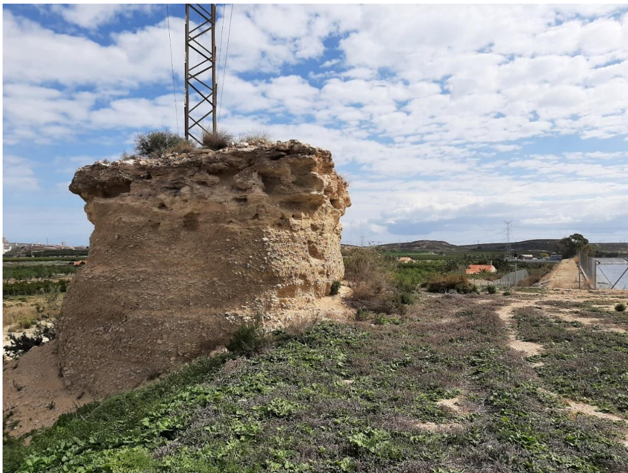
Ilustración 22. Gravas de la unidad Q_{TS} , a unos 100 m del P.K. 6+000 de la Alternativa de actuación.
