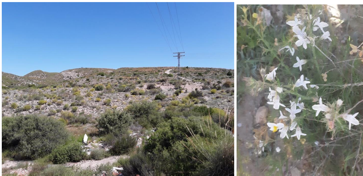
Ilustración 38: Vegetación de la sierra de los Colmenares (izquierda), por su lado sur (emboquille del túnel Los Colmenares). Se trata de un espartal, denso en la parte alta y más descarnada.. En la parte baja, debido a una mayor presión antrópica y a la presencia de un suelo menos descarnado, codominan el esparto y la albaida, y aparecen pies de espino negro. En esta zona, a su vez, existen zonas de matorral-pastizal con presencia de especies características del hábitat prioritario 6220, como Teucrium pseudochamaepitys (derecha).
