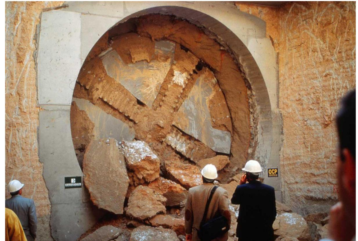
Figura 27. Imagen Tuneladora Metro Valencia línea 3-FGV
