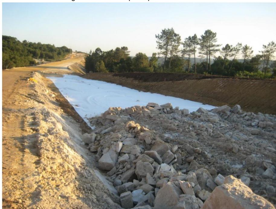
Figura 66. Relleno mejora con geotextil
