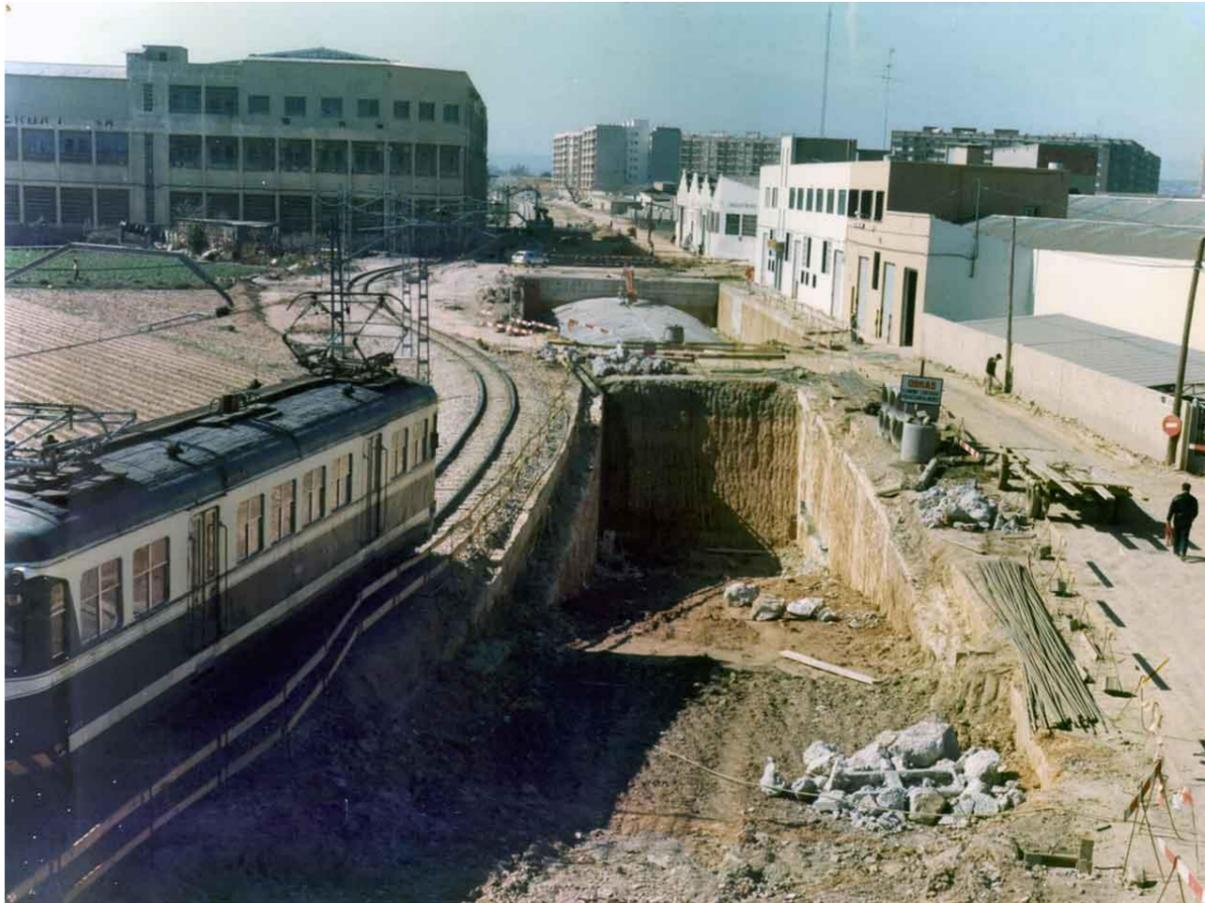
Figura 28. Excavación entre pantallas con bóveda prefabricada línea 1
