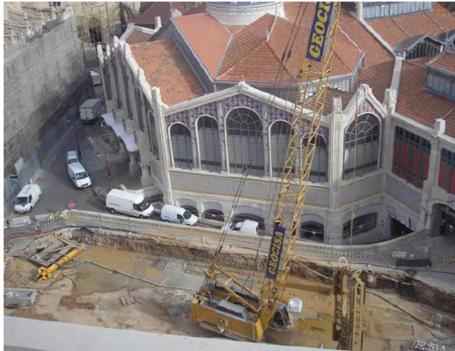
Figura 30. Excavación estación Mercado Central línea T2 FGV
