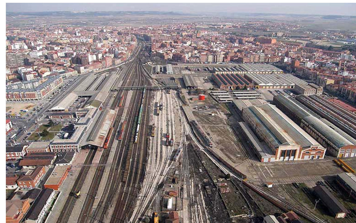
Imagen aérea actual de la estación y la zona de talleres
