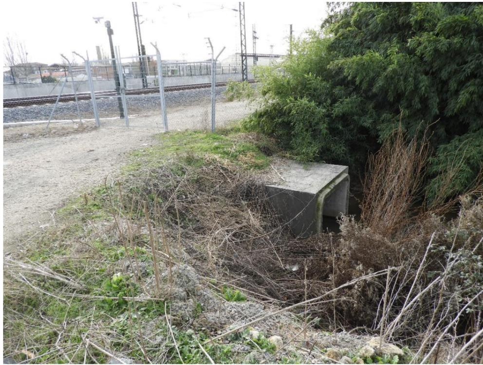
Imagen 11. Obra de drenaje transversal de sección rectangular de la infraestructura existente.
