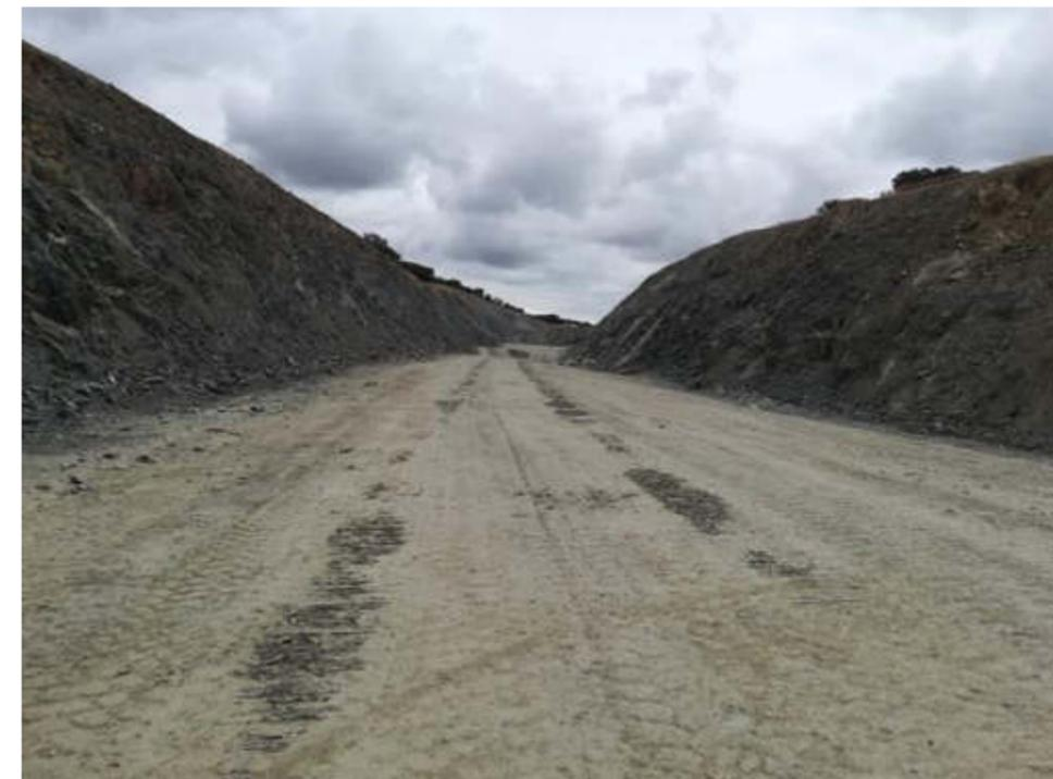
*Trinchera de la futura L.A.V. excavada en esquistos, unidad representativa del complejo esquisto-grauváquico de la zona. P.K. 10+380. Foto sobre el tramo Ramales de Conexión en Plasencia.*
