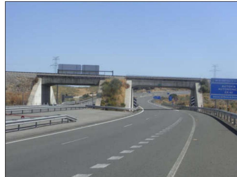
Fotografía 16. Paso inferior de la autovía autonómica EX - A1 bajo la vía de ff.cc. convencional (dirección Navalморal de la Mata).
