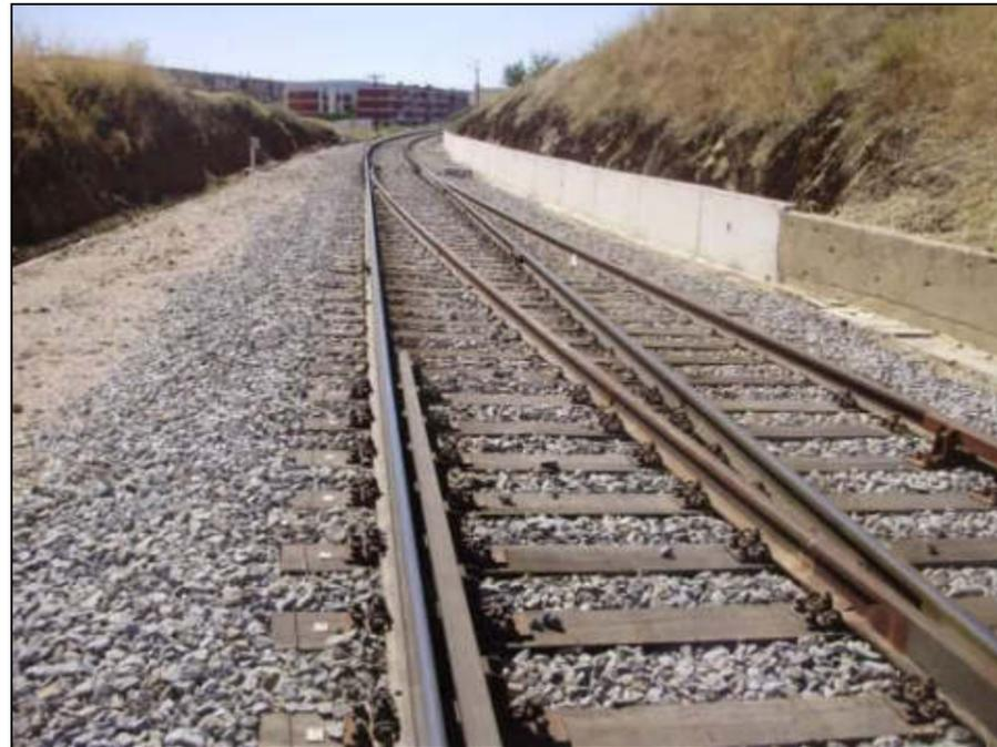
Fotografía 35. P.K. 16/450. Detalle del desvío entre las vías 2 y 1 en las proximidades de la Estación de Plasencia
