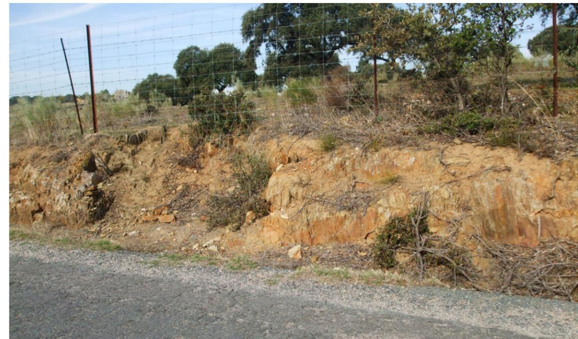
*Talud excavado en roca meteorizada de la formación Ceg, en la zona de cruce del tramo Malpartida de Plasencia – Estación de Plasencia/Fuentidueñas con la carreta CC-9102.*
