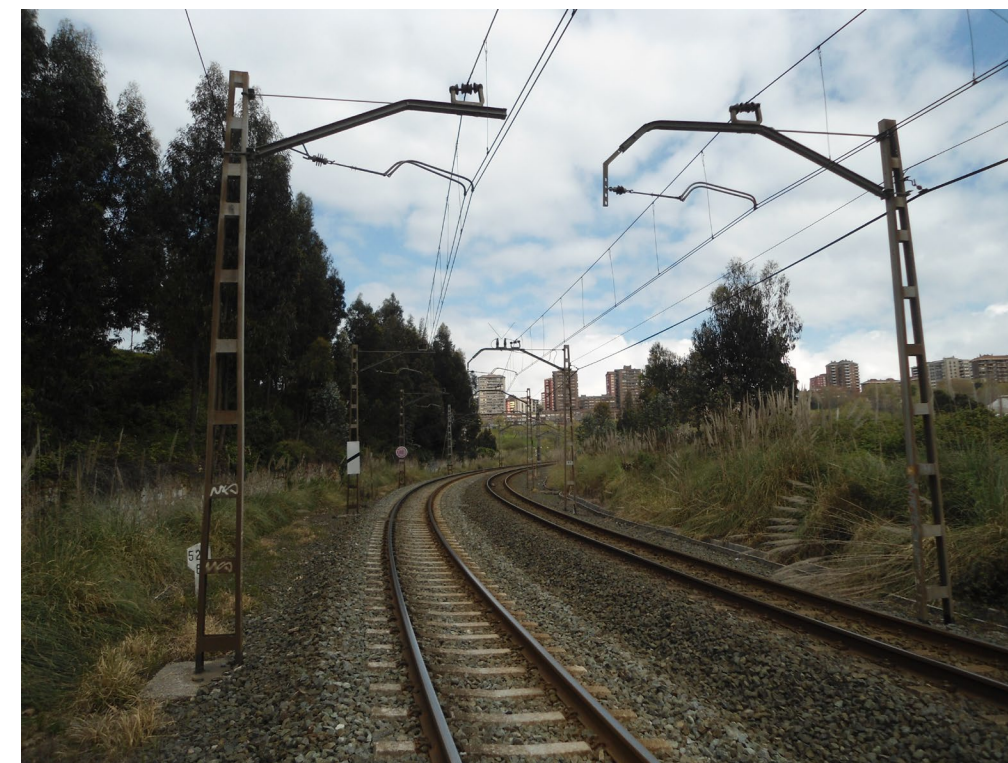
Figura 2. Zona del enlace en la línea RAM Oviedo-Santander.
