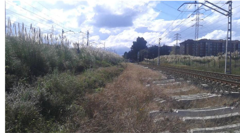
Fotografía Nº 3. Desnivel existente entre las vías de ancho métrico y la de ancho convencional.
