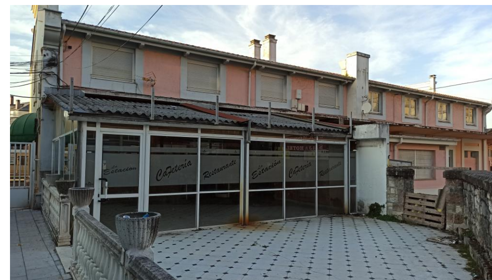
Vista de la cafetería desde la Plaza de las Estaciones.
