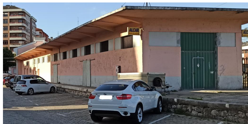
Vista del edificio auxiliar desde el aparcamiento de las estación.
