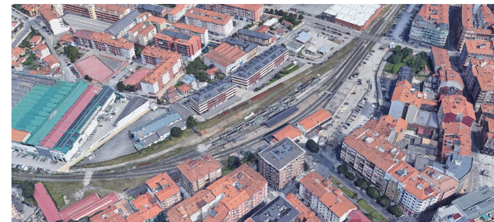
Imagen 1 Vista aérea del trazado de vías y edificaciones de la estación de Torrelavega (fuente: Google Earth)
