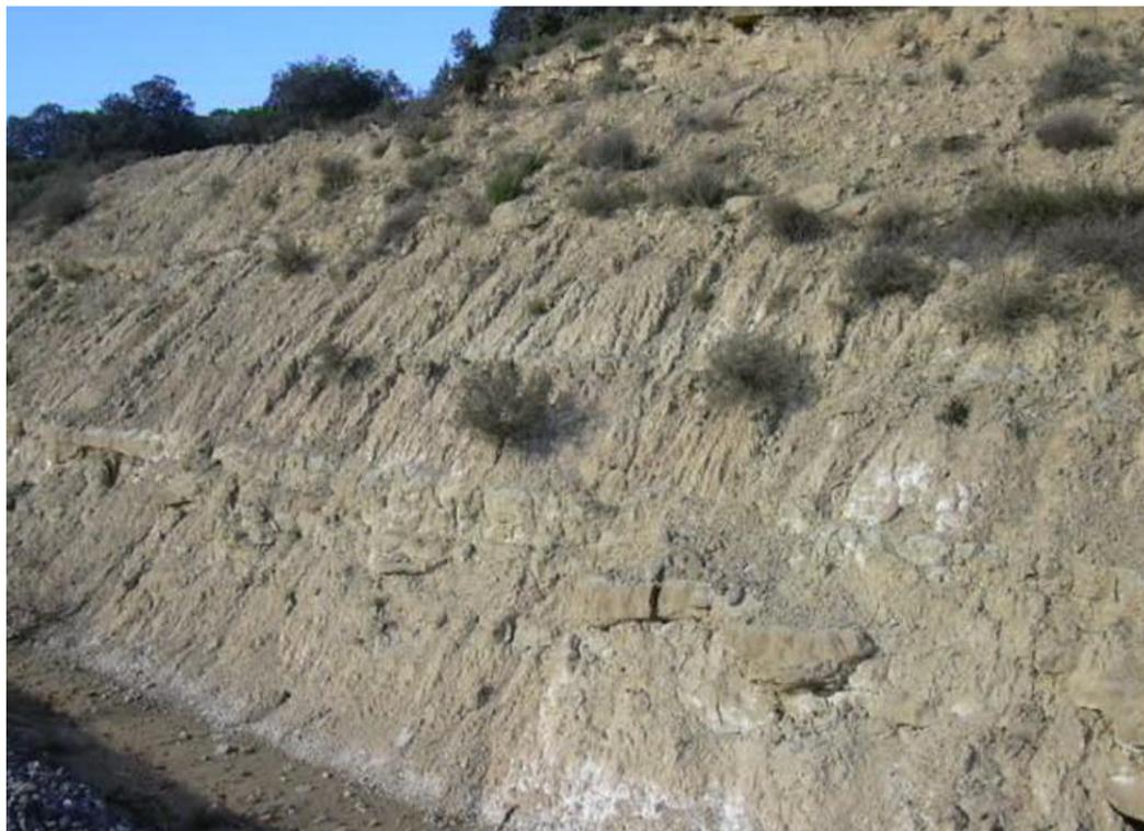
Figura 10 - Materiales de la unidad T23 atravesada por el túnel de El Conejo y observada en el talud T69 (fuente: PC línea Huesca – Canfranc. Tramo: Ayerbe – Caldearenas. Plataforma y vía)
