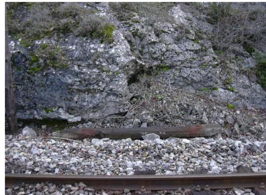
Figura 13 - Materiales de la unidad T12 atravesada por el túnel Lecinar, observada en el talud T-39 (fuente: PC línea Huesca – Canfranc. Tramo: Ayerbe – Caldearenas. Plataforma y vía)
