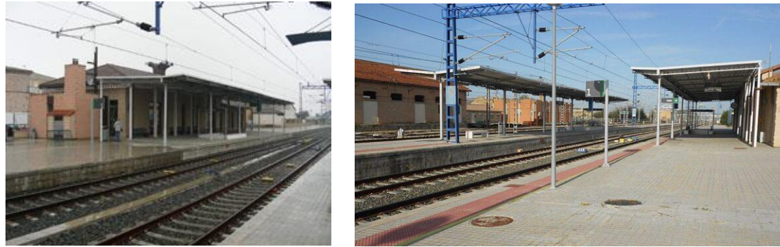
Edificio de la Estación. Fuente Adif/El Independiente
