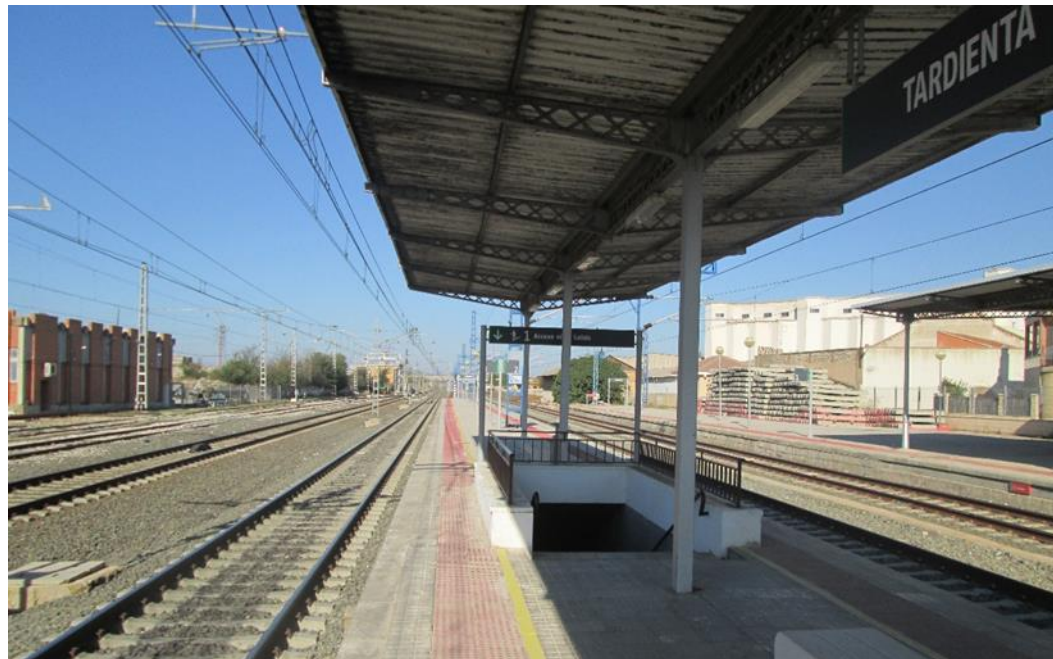
Paso inferior entre andenes. Fuente Ineco
