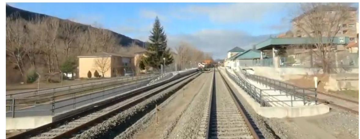
Rampas a paso inferior. Fuente propia
