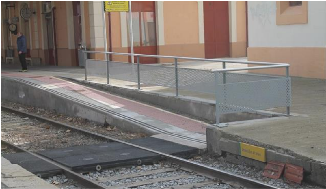
Rampa final andén recrecido. Fuente propia
