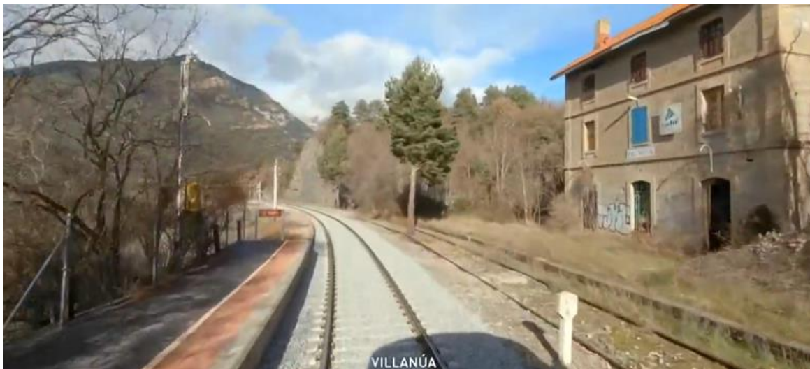
Andén y antiguo edificio. Fuente propia
