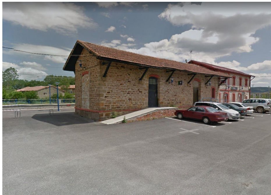
Edificio anexo al edificio de viajeros, antigua cafetería.
