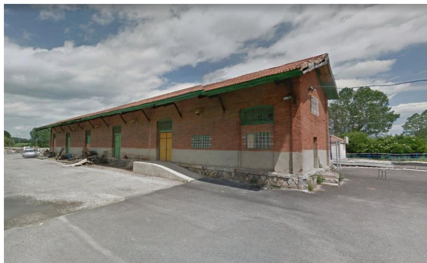
Nave anexa al andén 3 situada junto al muelle de las vías en topera.
