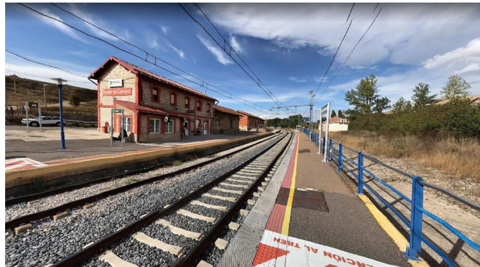
Vista del andén 1 y del Edificio de Viajeros, sentido Santander.
