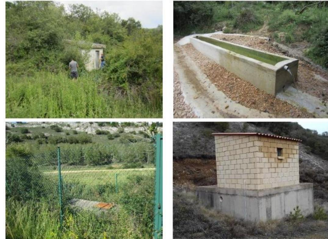
Figura 47. Abajo, aspecto de la caseta donde se capta el manantial (PA-009) y del abrevadero que recoge el sobrante. Abajo, Aspecto del manantial de Fuente Prado (PA-088) y depósito en el que se realiza la cloración del agua.
