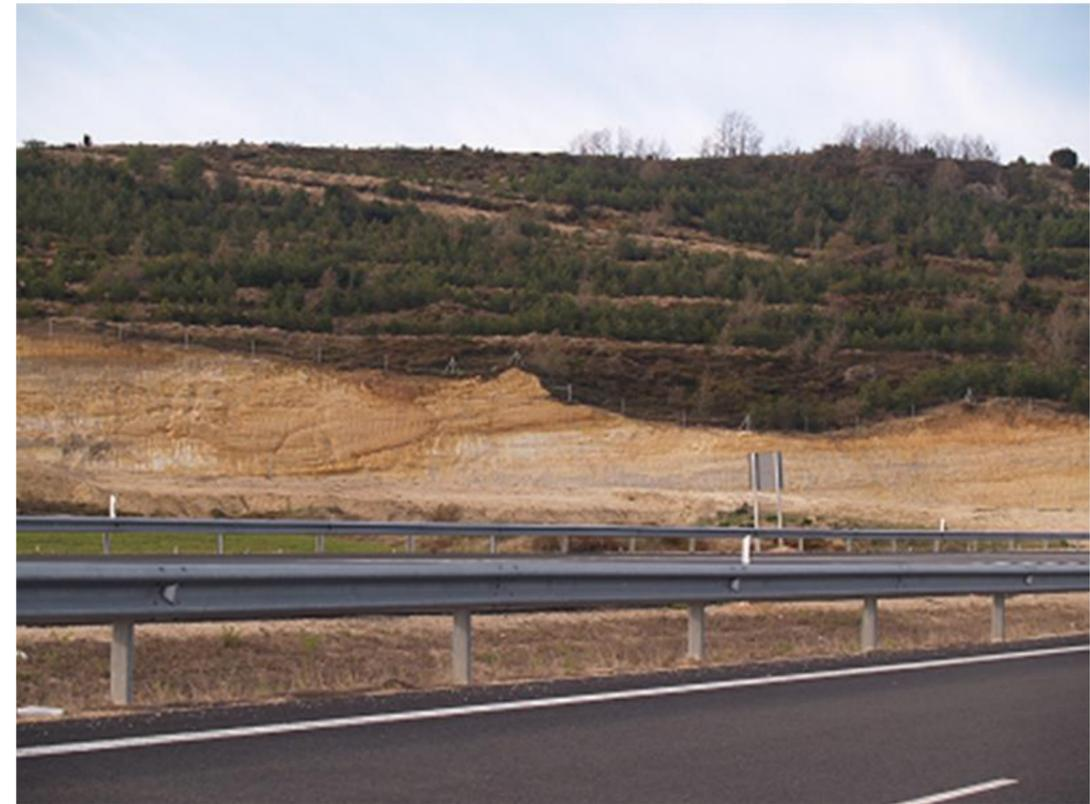
Figura 25. Talud excavado en las arenas de Utrillas (C6). Actualmente este talud se encuentra reforzado por escollera y geotextil con hidrosiembra, debido a los problemas de acarreamiento que presentó.
