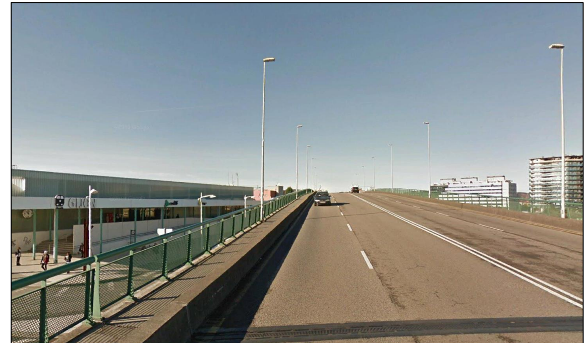
Paso Superior de Carlos Marx a su paso junto a la Estación Provisional de Sanz Crespo
