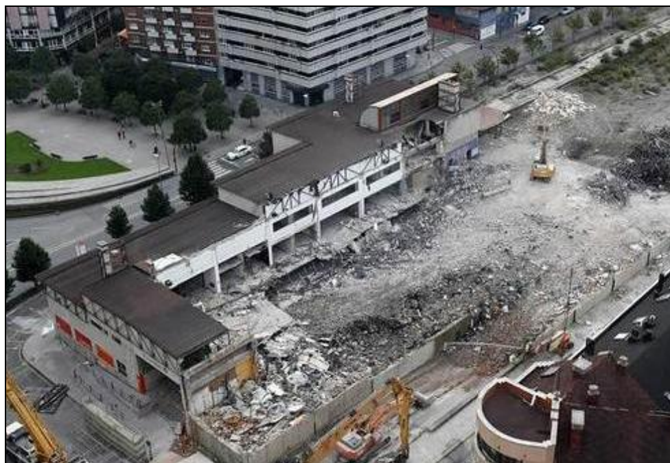
Demolición estación El Humedal
