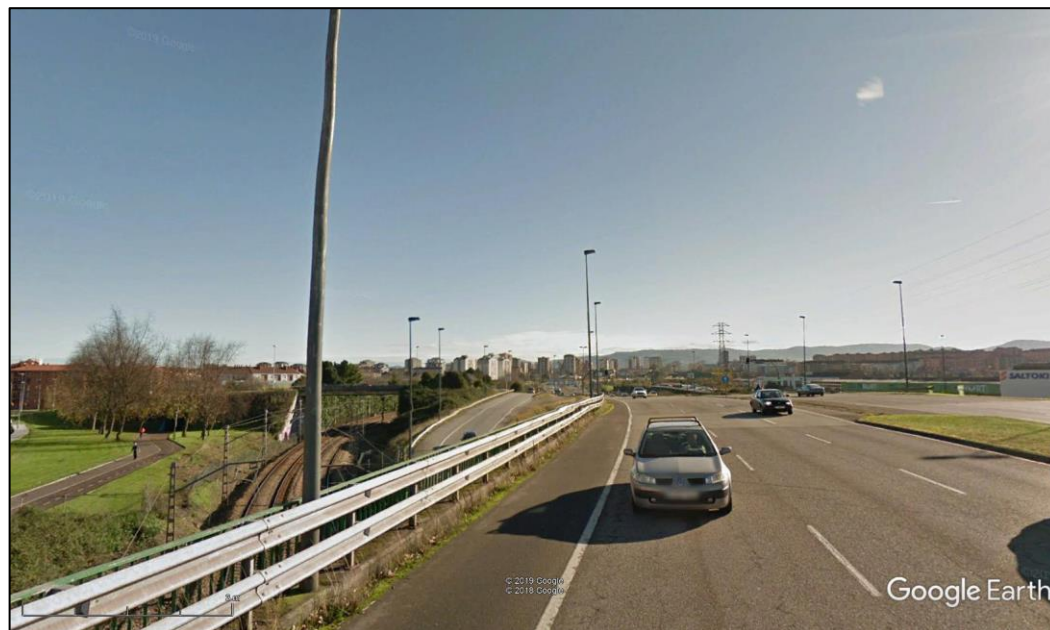
Avenida Príncipe de Asturias a su paso sobre las vías de cercanías de ancho ibérico.
