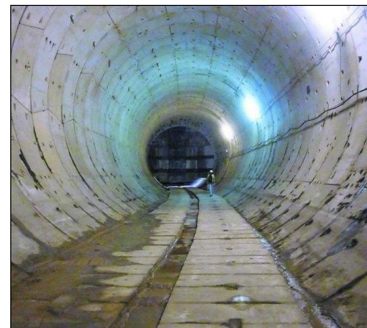
Túnel de penetración en Gijón
