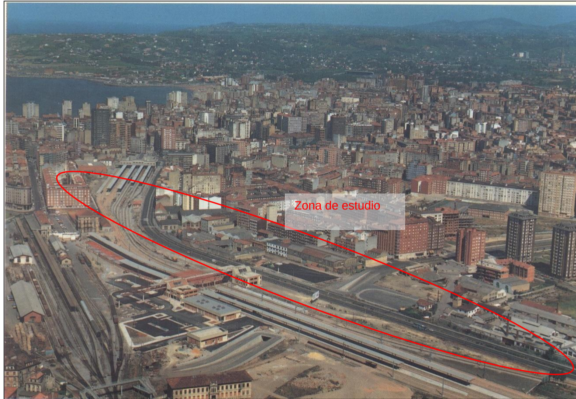
Fotografía aérea de la antigua estación de ferrocarril de Gijón y la estación de Jovellanos a finales del Siglo XX. Compárese con la fotografía anterior.
