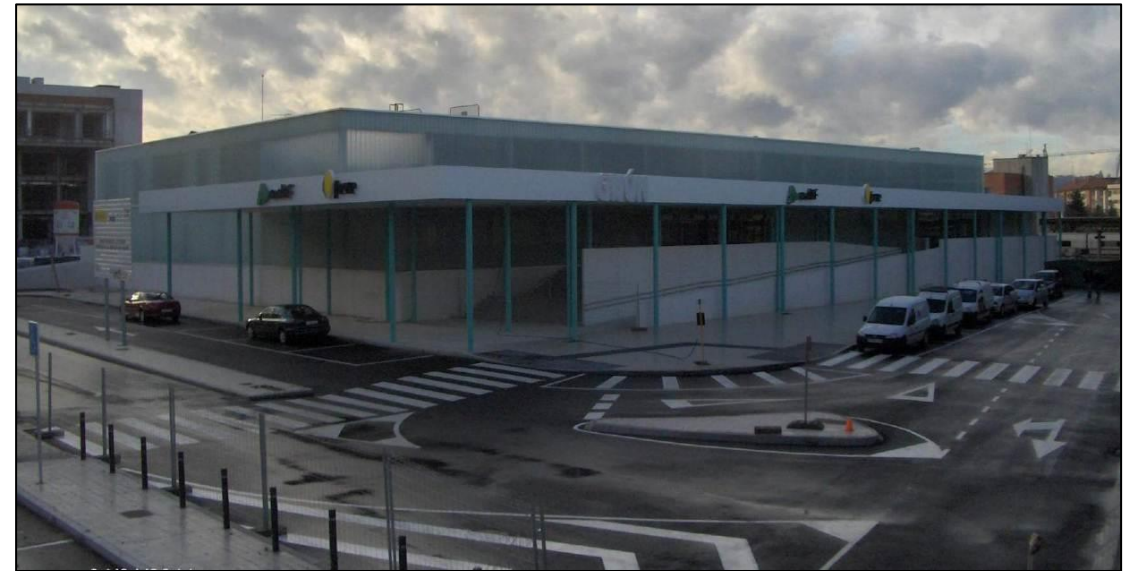
Estación provisional de Sanz Crespo. Edificio de viajeros
