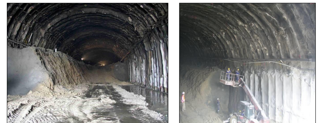
Foto 7.3. Sostenimientos en fase de avance y destroza de un túnel
