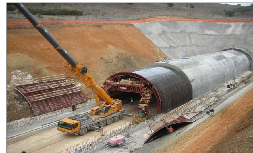
Foto 7.5. Construcción de un falso túnel
