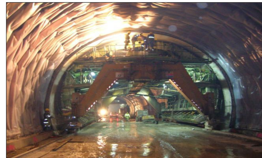
Foto 7.4. Bombeo de hormigón de revestimiento sobre autocimbra
