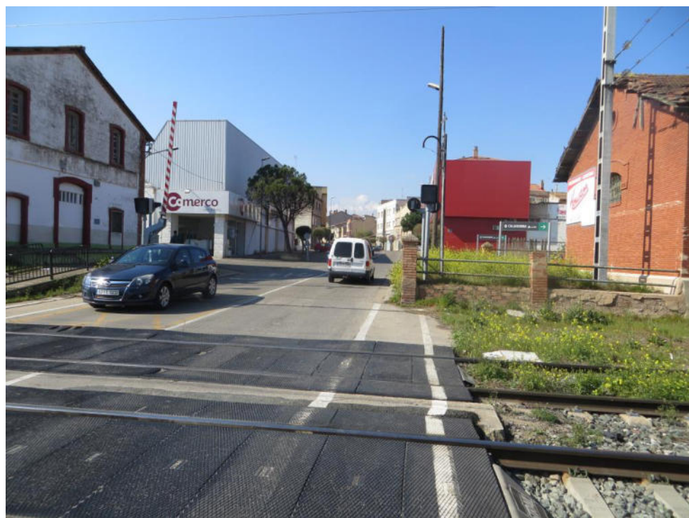
Paso a nivel de Calahorra
