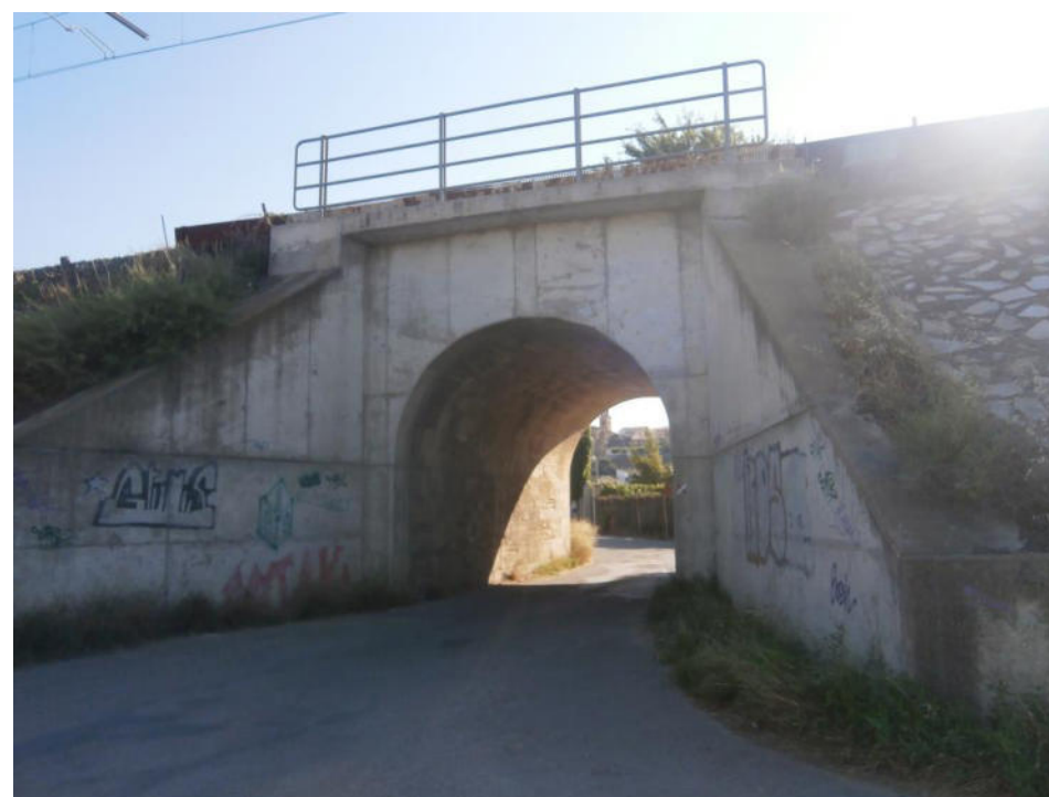
Paso Inferior de la vía pecuaria (Vista desde la calle de la Algarrada)
