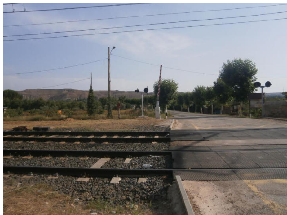
Paso a nivel de Alcanadre y camino con arbolado
