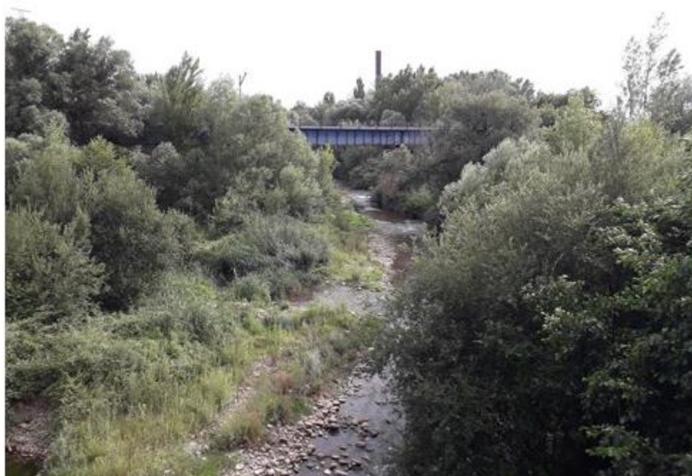
Estructura existente del FF.CC. Castejón-Bilbao sobre el río Iregua a su paso por Logroño
