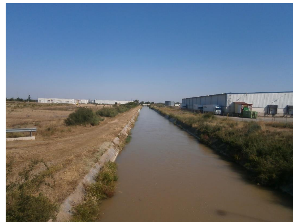
Canal de Lodosa a su paso por Calahorra
