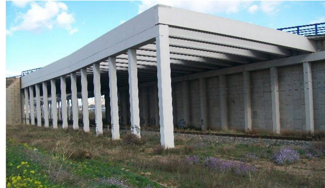
Autovía LO-20 con pérgola sobre la línea férrea en zona de paso del Río de Valsalado
