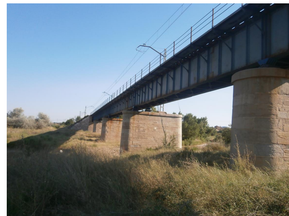
Vista del viaducto actual en el cruce del FF.CC con el río Cidacos
