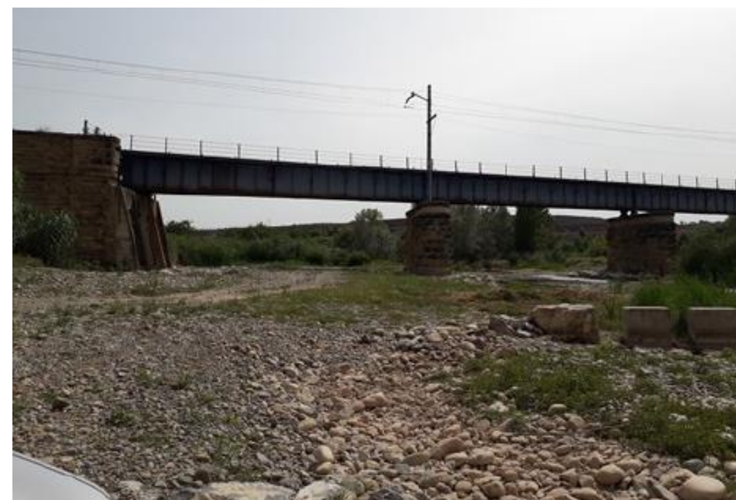
Vista de la estructura existente en la línea férrea actual en el cruce con el río Leza
