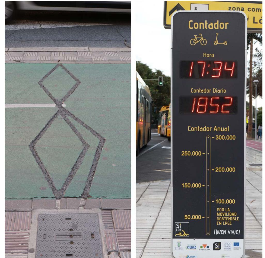
Fotografía 8.6 Espiras para aforo en vía ciclista y panel informativo con aforo diario de bicicletas
