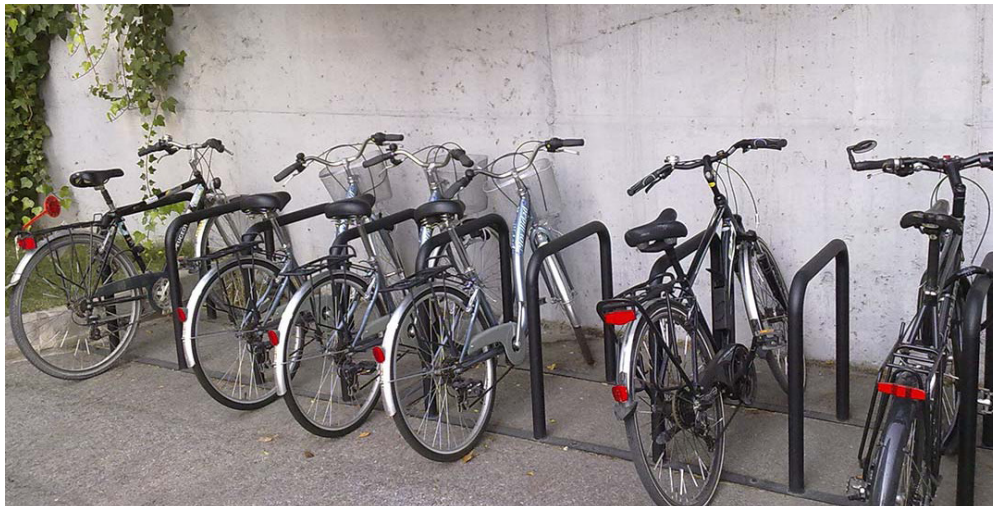
Fotografía 7.6 Aparcabicis U invertida (con anclaje de barra transversal)
